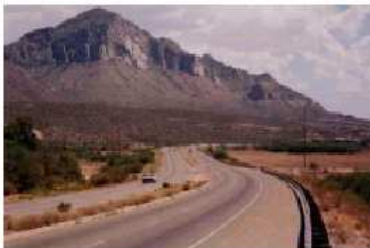
Rodovia de Múltiplas Faixas Dividida em ambiente rural
