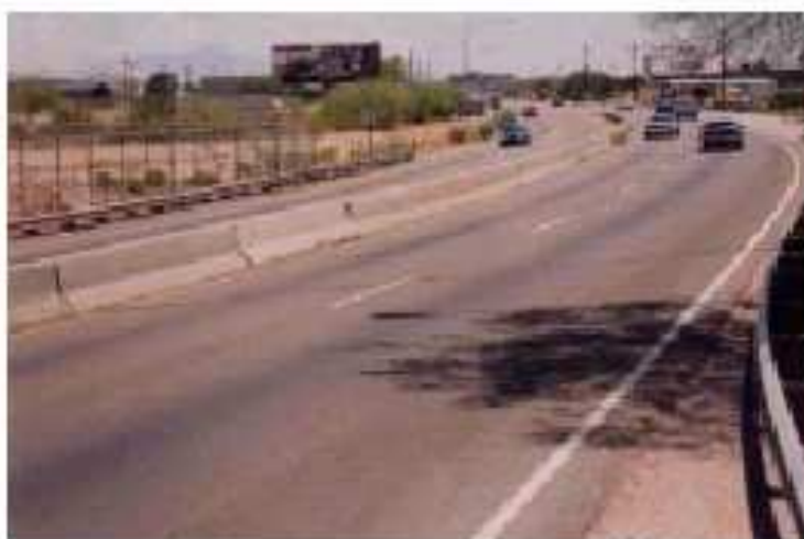
Rodovia de Múltiplas Faixas Dividida em subúrbio.
