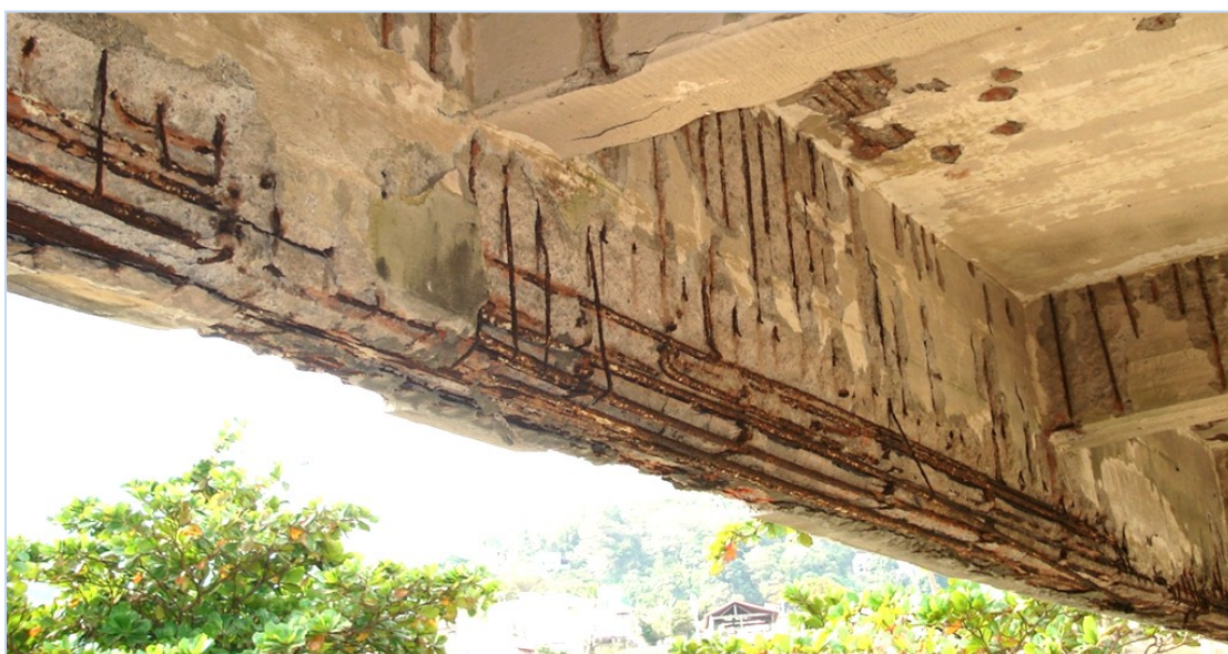
Viga - O cobrimento também era pequeno.
