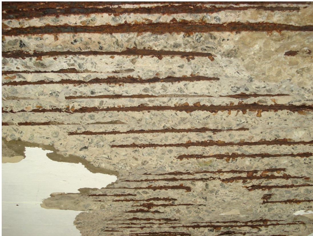
Laje - O cobrimento era mínimo.
