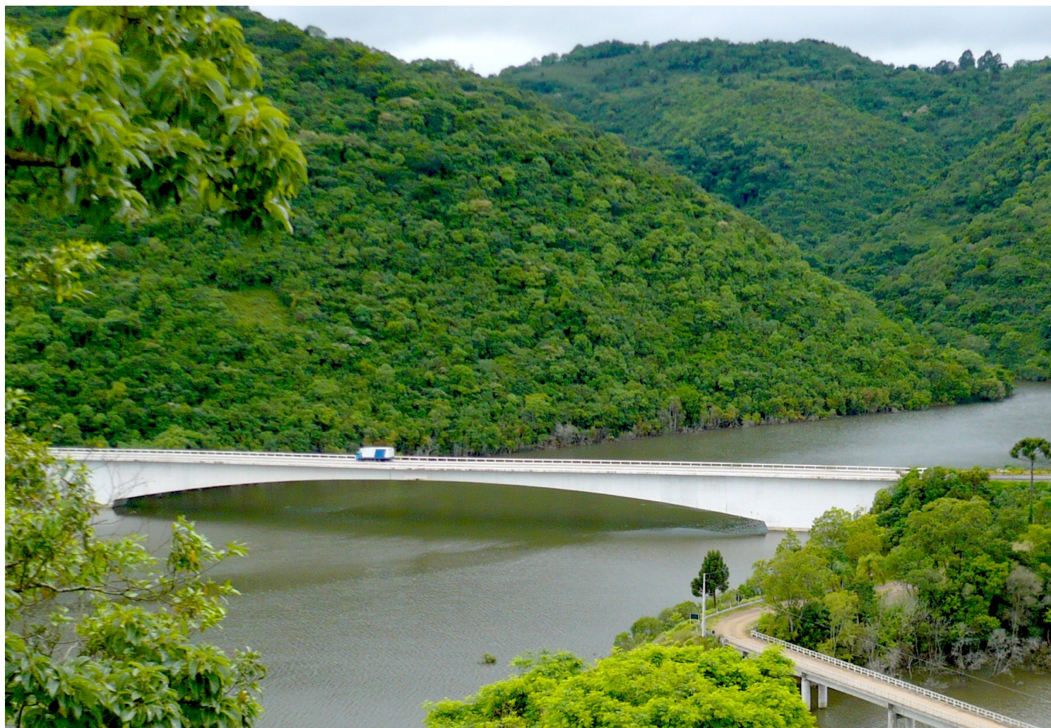
Fig. 6 - Foto em 2011, com a ponte “afogada” pelas águas represadas do rio Pelotas. Uma barragem a jusante da ponte elevou o nível das águas.
