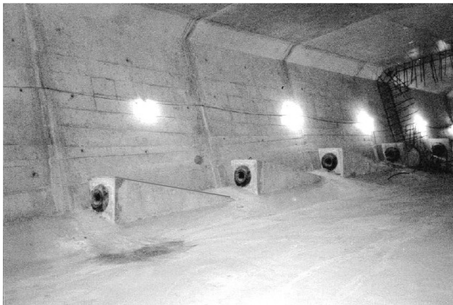
Ancoragem dos cabos inferiores
