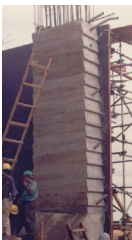
Balanços executados com Aduelas Pré-moldadas
