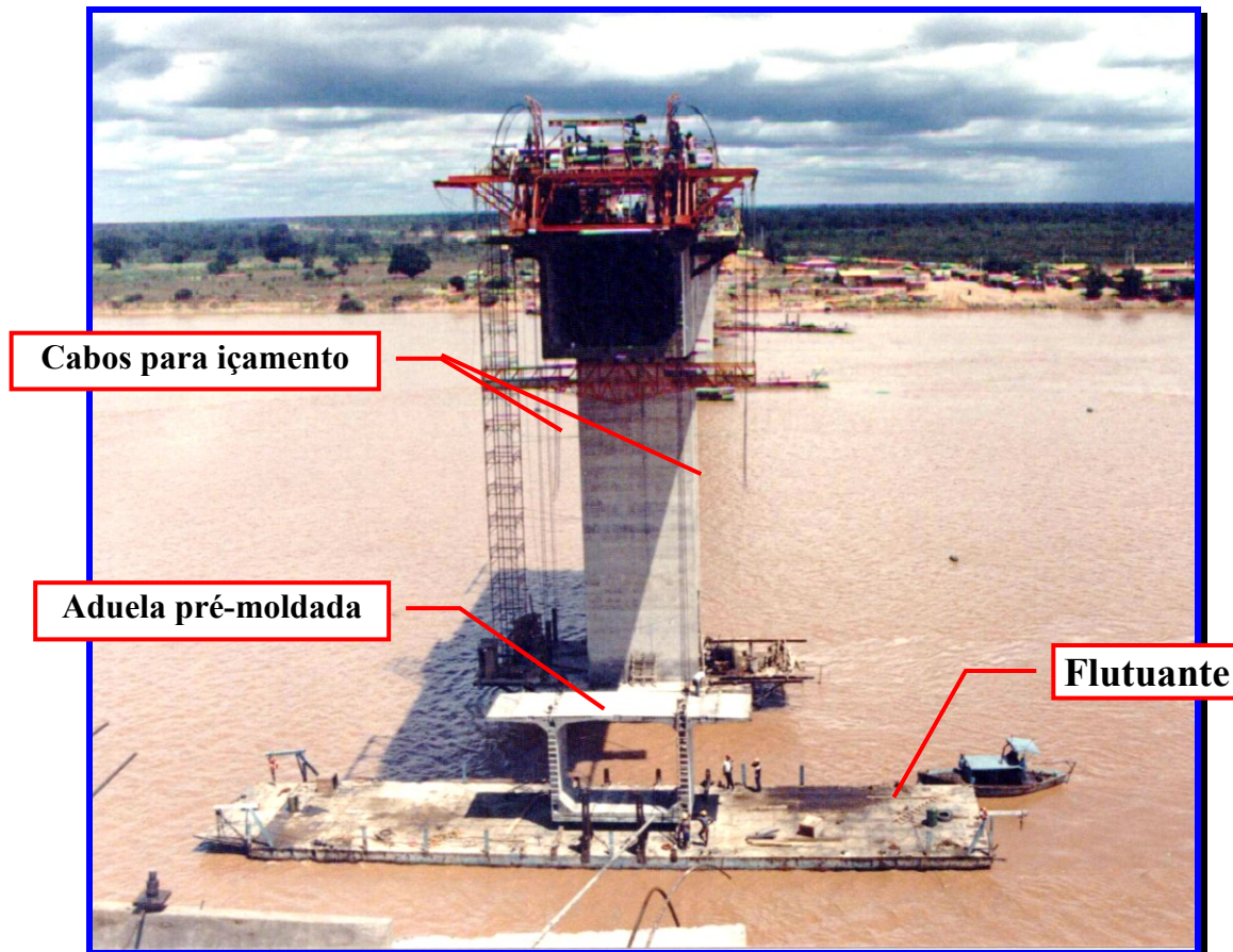
Transporte fluvial, içamento e Montagem das aduelas pré-moldadas
