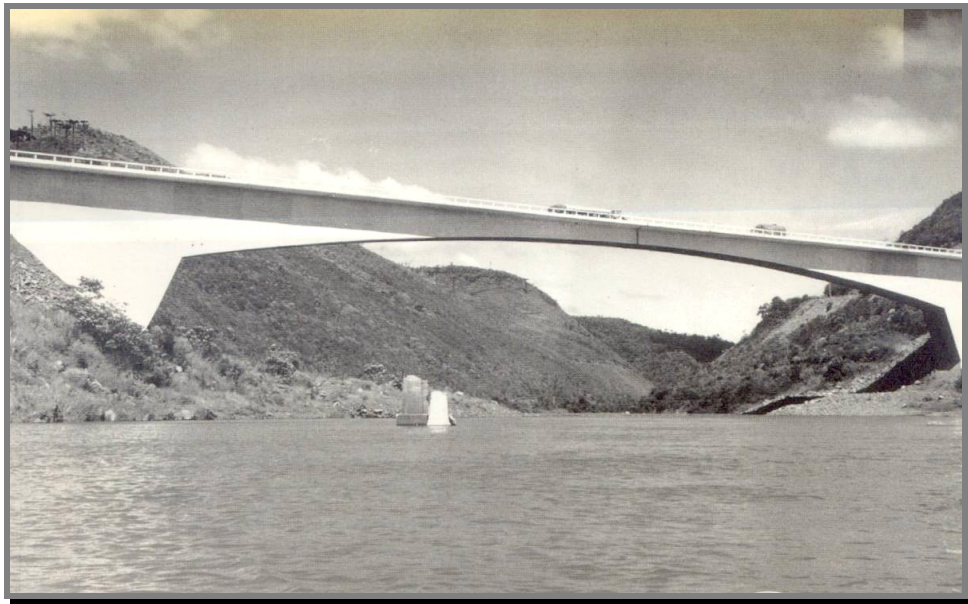
Fig. 3 Ponte sobre o Rio Pelotas - Vão central 189 m Divisa do Rio Grande do Sul com Santa Catarina - 1966/1967
