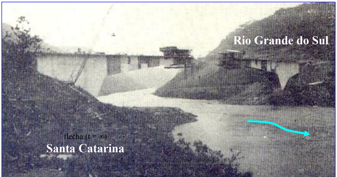
Fig. 4- Ponte sobre o Rio Pelotas - Fase de execução – 1966/1967
