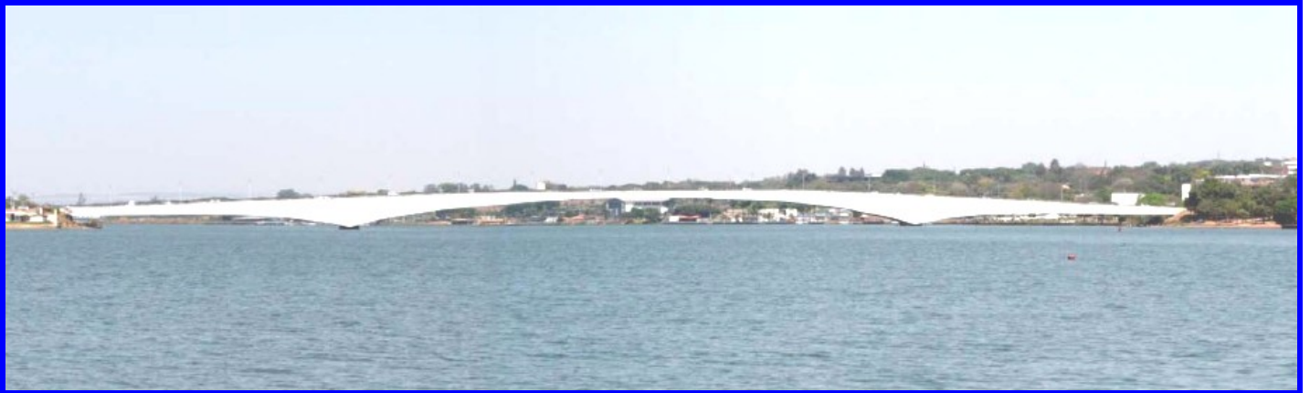
Figura 19a – Ponte em concreto protendido + Vão Gerber de aço.
