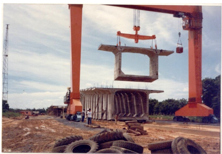
Estocagem das aduelas pré-moldadas
