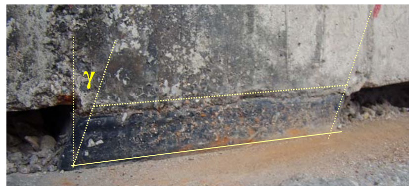
Aparelho de Neoprene, com várias camadas de Neoprene , em uma ponte, após a deformação longitudinal Foto: Cortesia Eng. Alexandre C. Cordeiro
