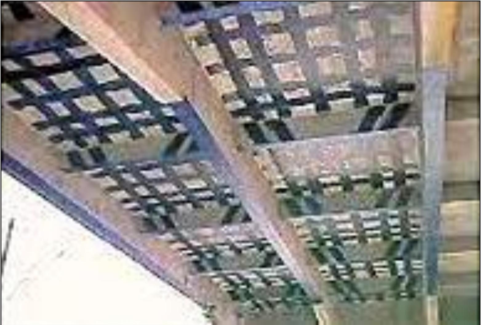
**DEVIDO AO AUMENTO DAS CARGAS NAS RODAS DOS CAMINHÕES, SÓ AS LAJES FORAM REFORÇADAS COM FIBRA DE CARBONO.**
