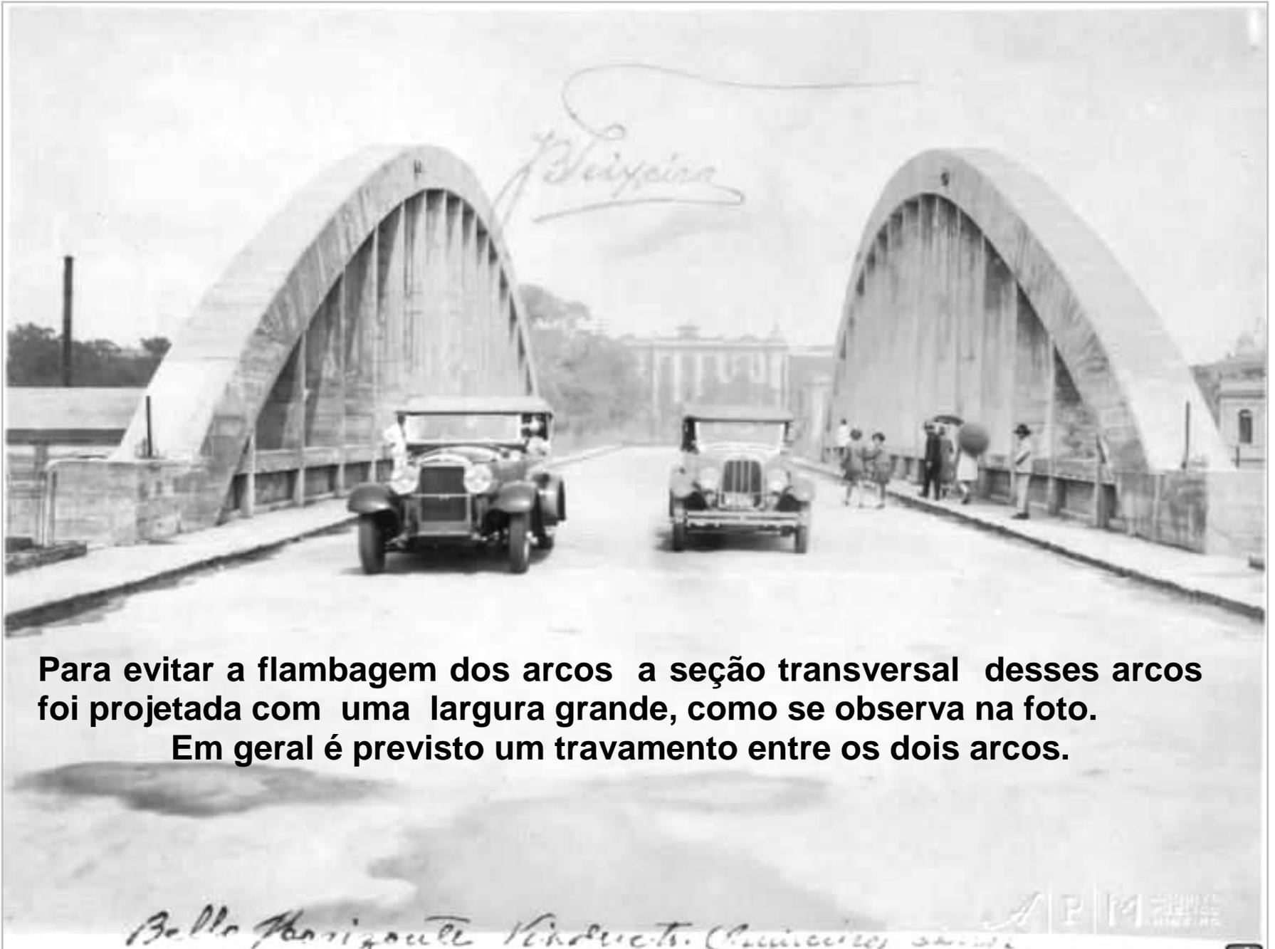
**Para evitar a flambagem dos arcos a seção transversal desses arcos foi projetada com uma largura grande, como se observa na foto.
