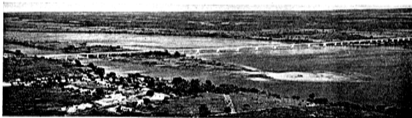
Fig. 3 — Vista geral da obra
