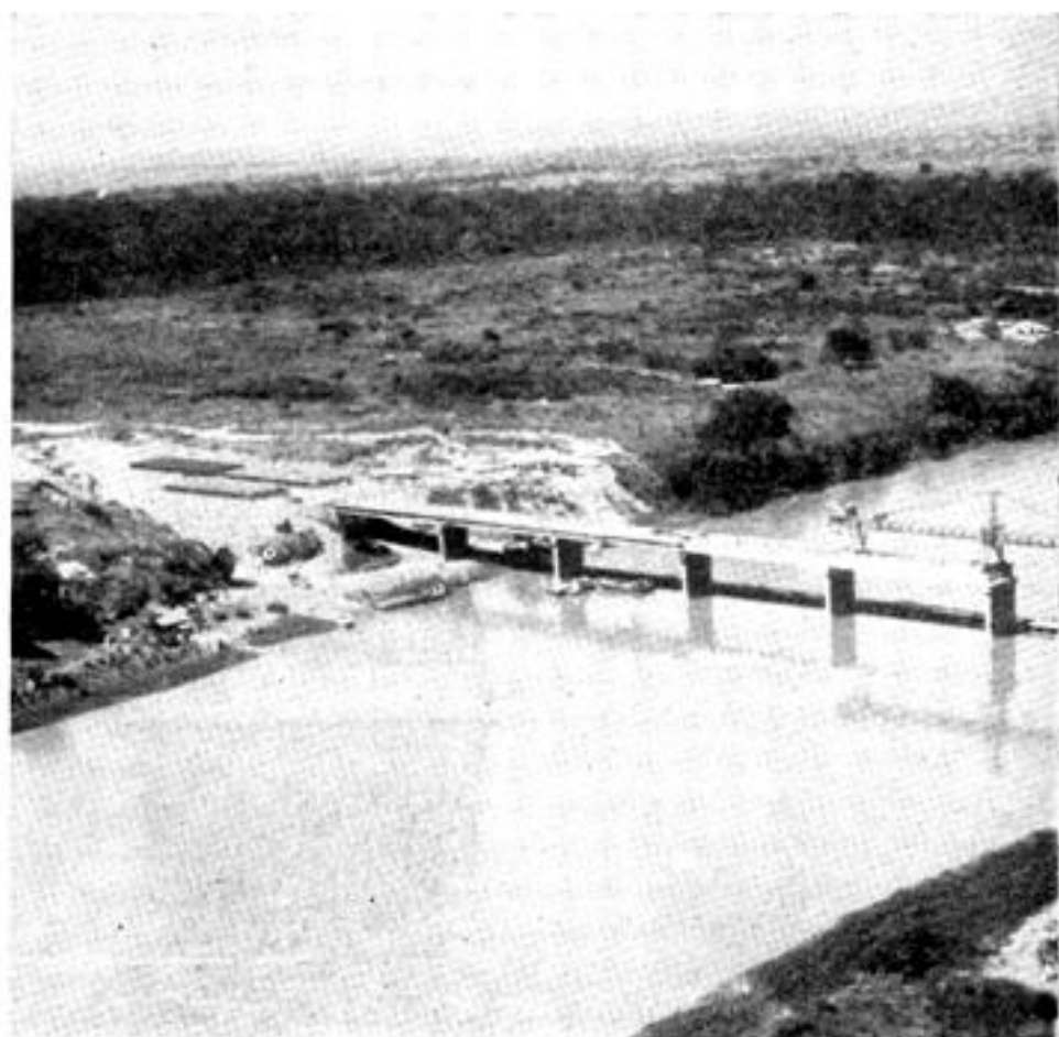
Foto 5 — Vista aérea. Canteiro das vigas vãos de 45 m. no canal não nave- gável. Parte da treliça
