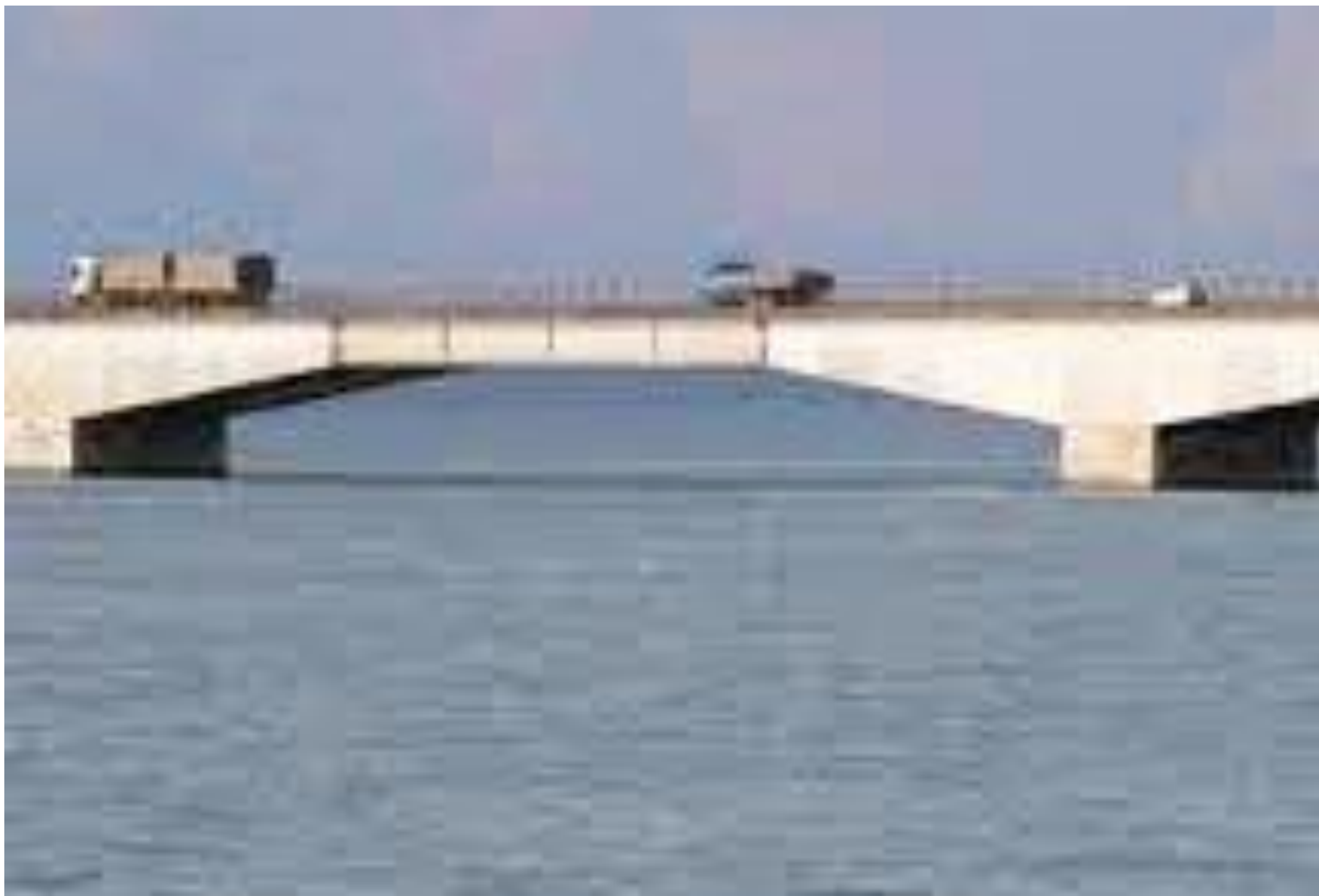
APÓS A CONSTRUÇÃO DE BARRAGEM A JUSANTE
