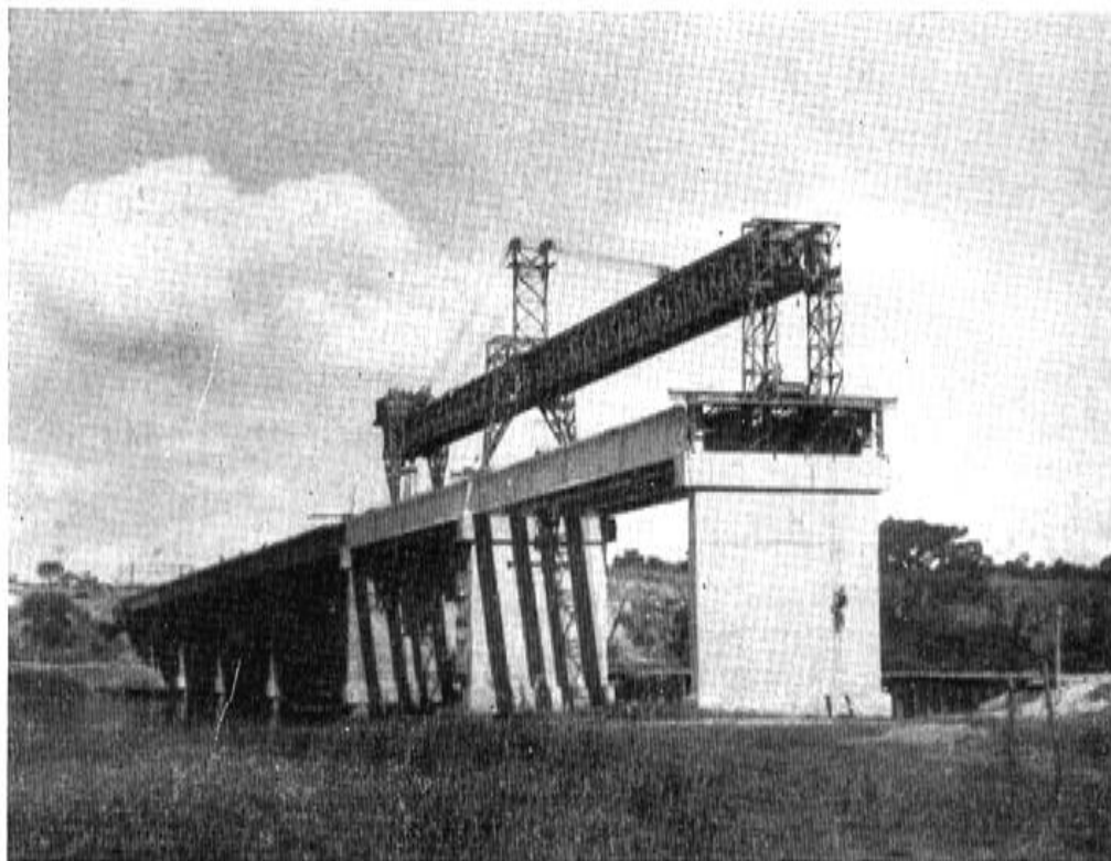
Foto 1 — Vãos de 45 m. Vista da treliça de lançamento das vigas
