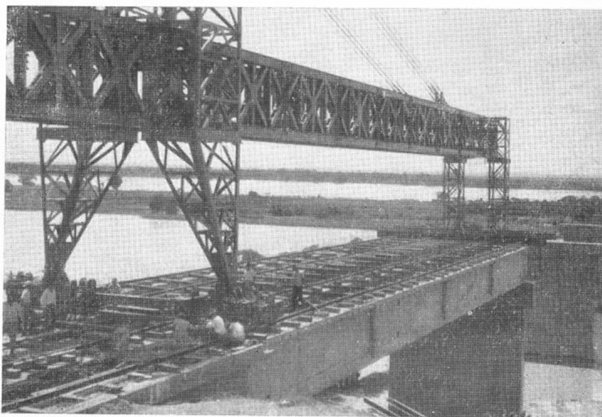
Foto 16 — Dormentes e trilhos para a movimentação da treliça
