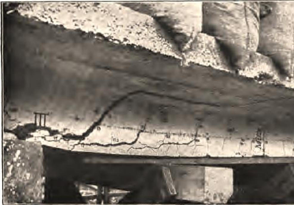
Foto da ruptura no lado esquerdo da viga III, sem estribos ou barras transversais
