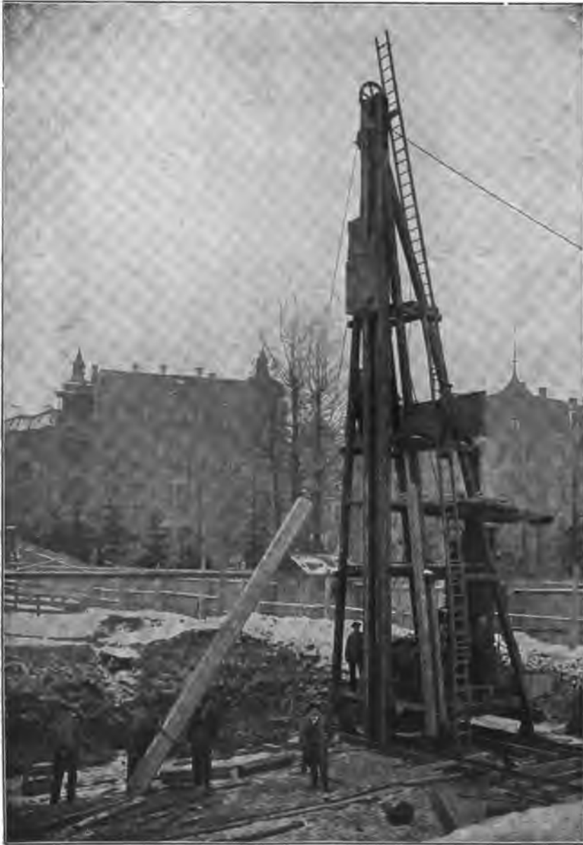
FIG. 268.—Station in Cannstatt. Hoisting piles.
