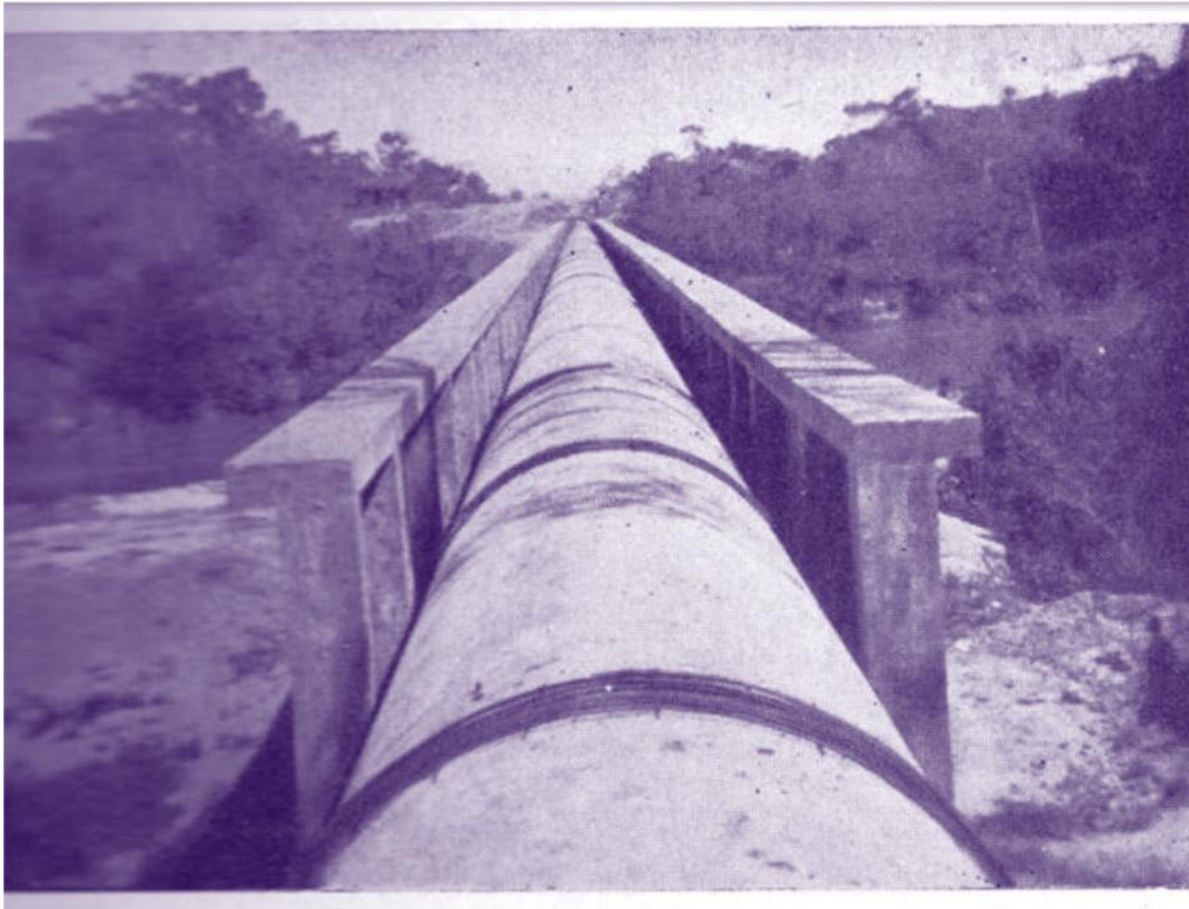
TRECHO DA 1 a ADUTORA LOGO APÓS INAUGURADA EM 1940. TRAVESSIA DO RIO GUANDÚ.
