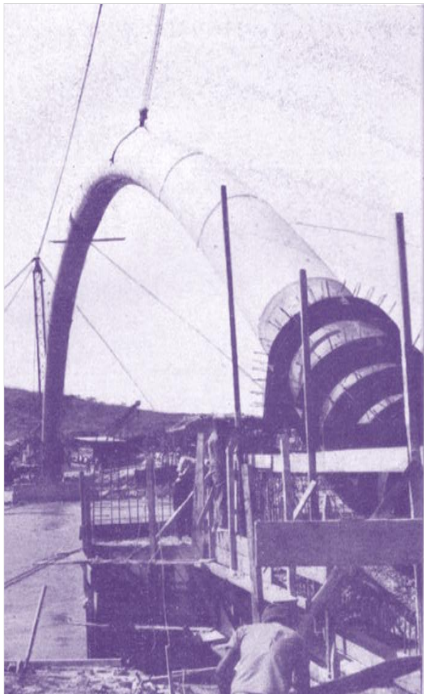
Foto n.º 6 — Bloco de ancoragem — armadura,
