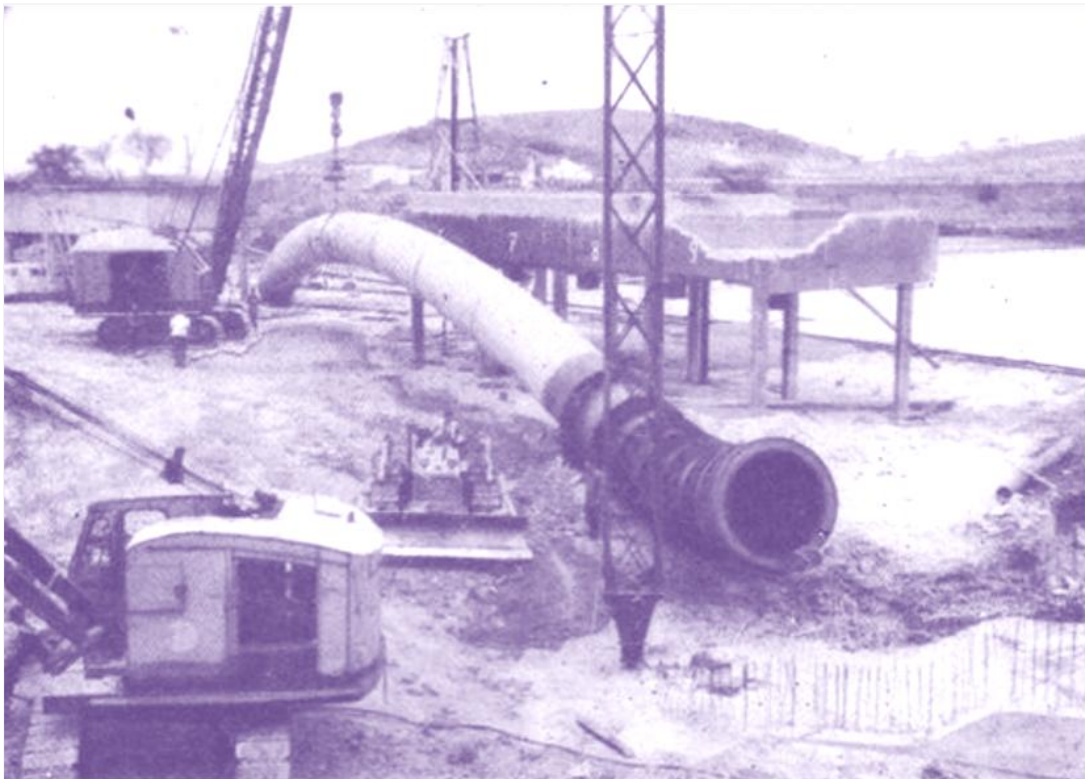
Foto n.º 2 — Semi-arco soldado à curva de ancoragem Margem Esquerda do rio.
