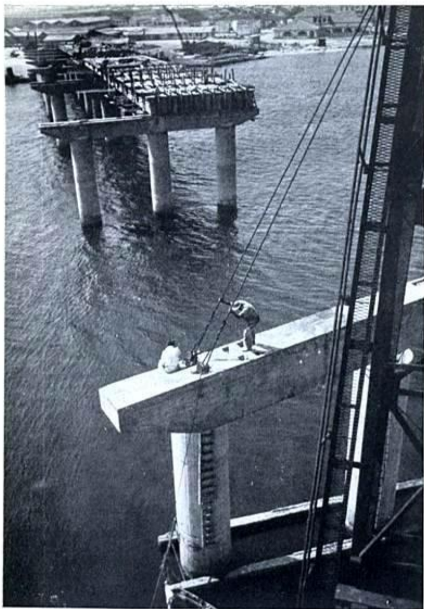
Ponte do Galeão na parte da ilha do Governador Galeão bridge, on a section of Governor island Puente de Galeão en la parte de la Isla del Gobernador, en Rio de Janeiro
