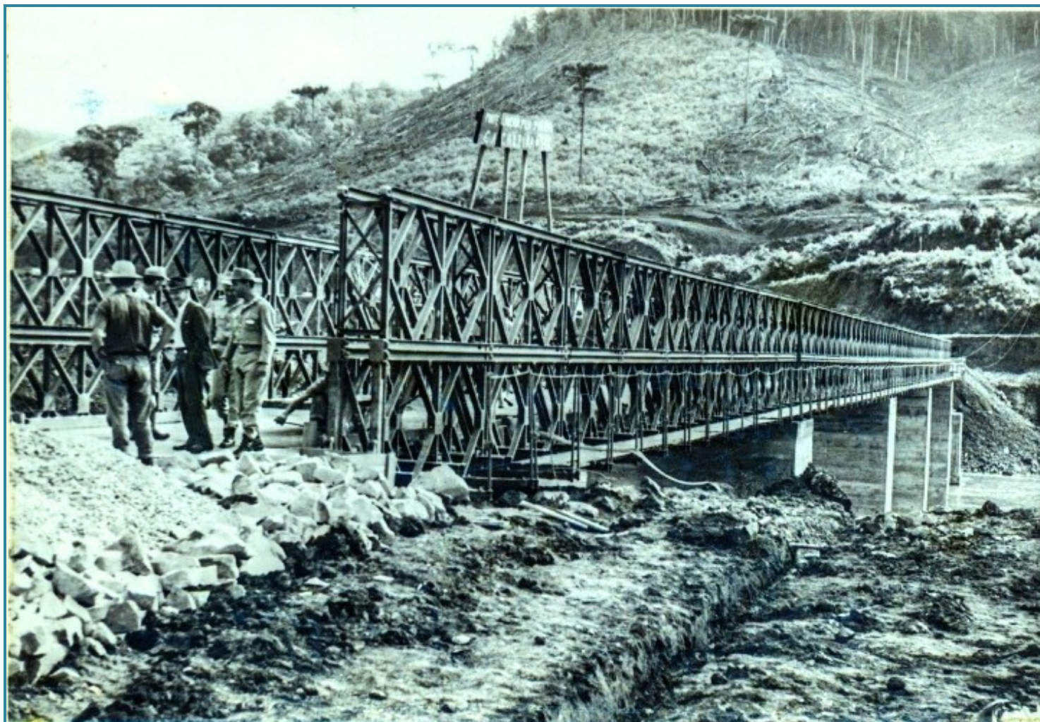
TRELIÇA BAILEY DO EXÉRCITO - PONTE SOBRE O RIO PELOTAS EM PASSO DO SOCORRO - COMPRIMENTO TOTAL - 250 METROS
