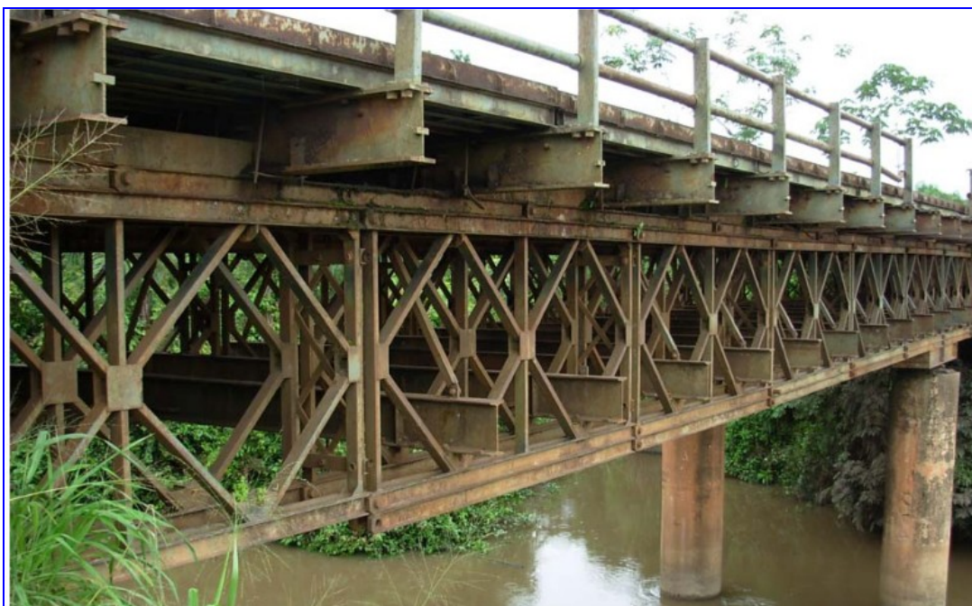
Ponte Sobre o Igarapé Flexeiro
