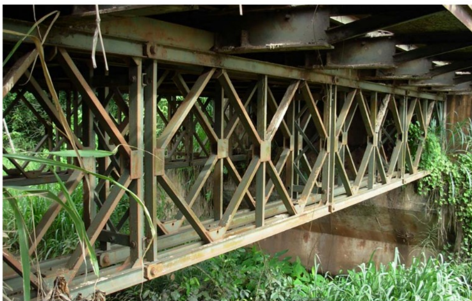
Ponte Sobre o Igarapé Grotão
