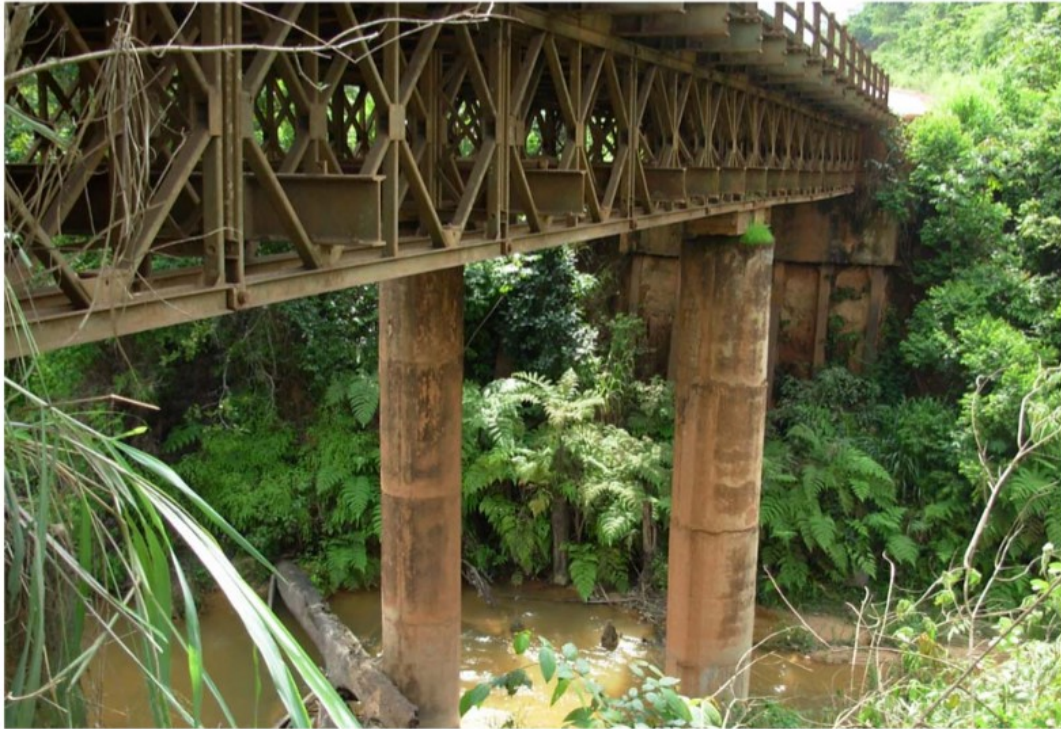
Ponte Sobre o Igarapé Brejo Grande II
