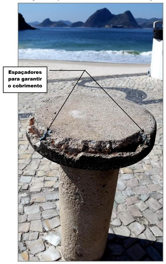
O concreto foi intencionalmente executado poroso, com pouco cimento, para apresentar uma textura rústica. Foi tomado o cuidado de garantir o "cobrimento" correto das armaduras, mas, através dos poros do concreto poroso, as armaduras foram atingidas pela maresia contendo cloro. A corrosão da armadura ocorreu.
