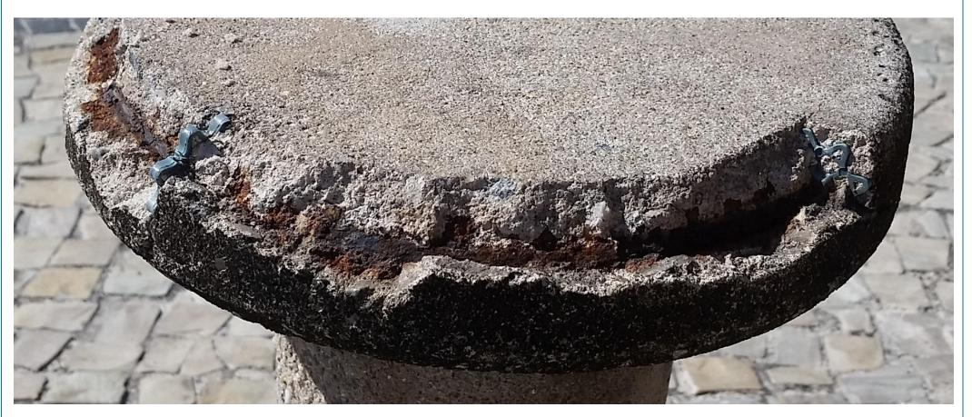
Embora seja necessário, não é suficiente cuidar apenas do "cobrimento" das armaduras. Um "traço" correto do concreto, rico em cimento, também é indispensável.
