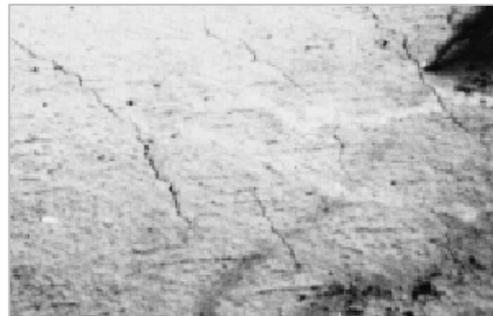
O espaçamento observado entre as fissuras “paralelas” varia até 60cm.
