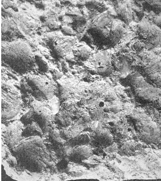
Superfície do concreto após perder “escamas”
