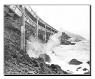
O mar batendo nas pedras molha a estrutura com água contendo cloretos e sulfatos. A névoa salina mantém a estrutura permanentemente em um ambiente agressivo.
