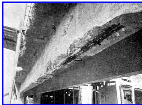
Os ferros longitudinais corroídos “explodiram” o cobrimento.
