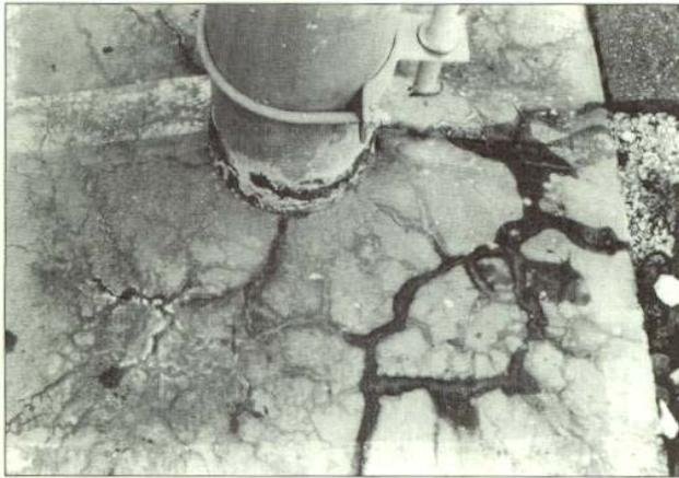
← Fissuração na Base de Concreto Armado, de uma torre de rede elétrica .
