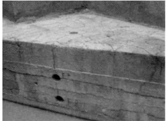
Blocos de fundação com reação Álcali × Sílica ( Recife / Pe)
