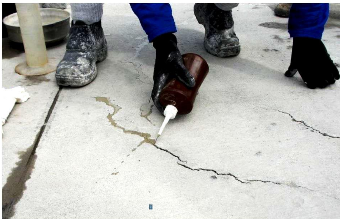
Figura 85 - Aplicação de microcimento por gravidade
