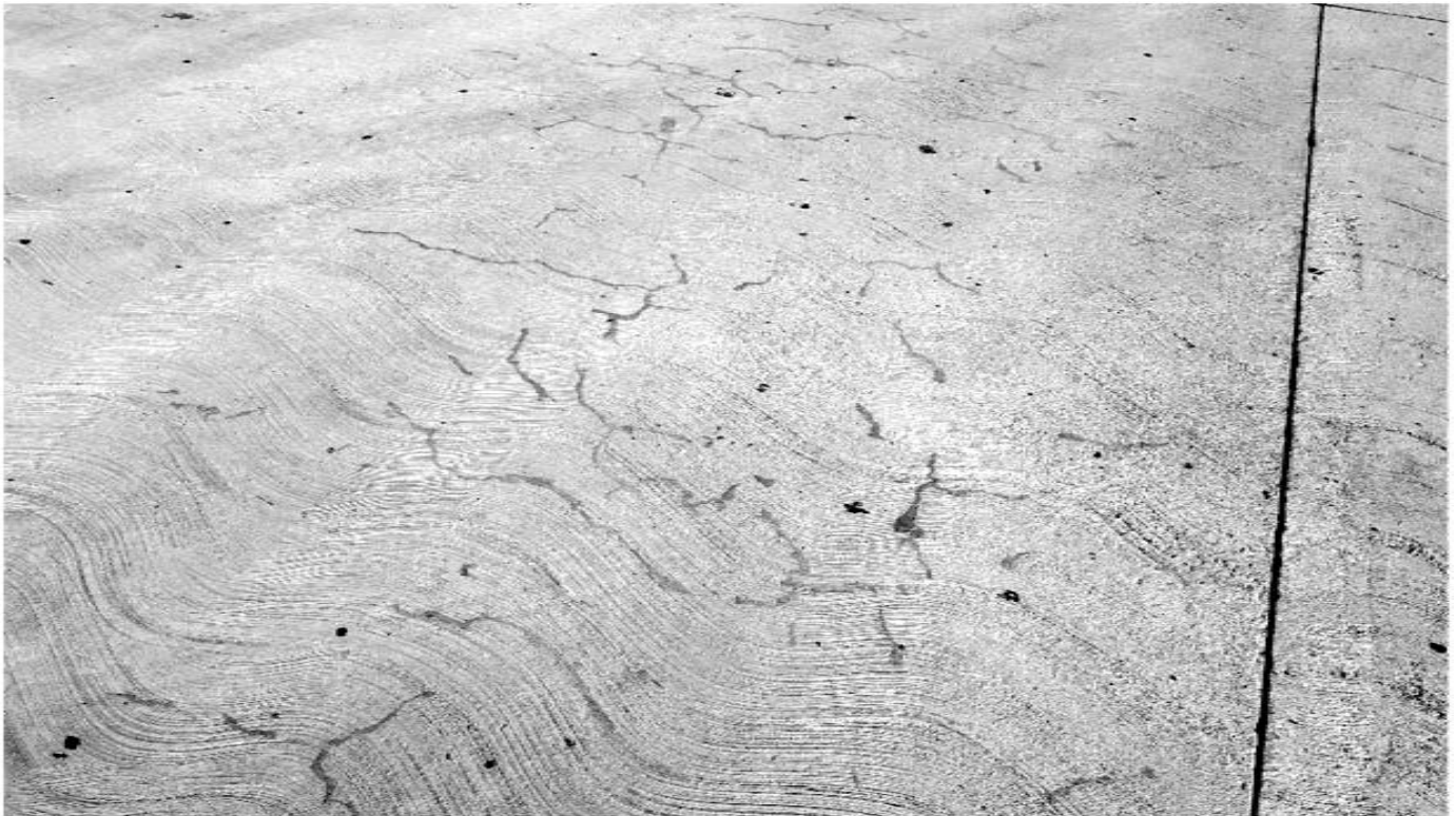
Figura 86 - Selagem de fissuras de retração plástica
