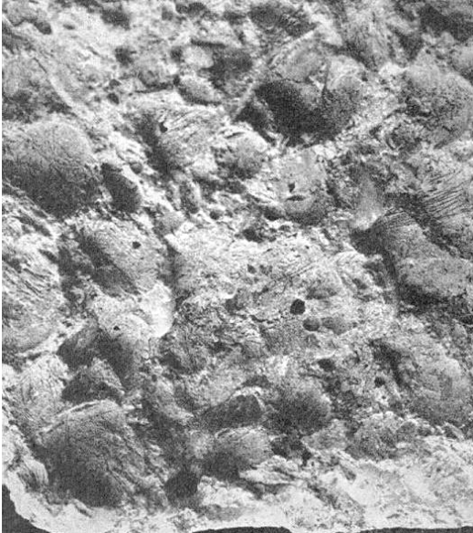
Superfície do concreto após perder “escamas”
