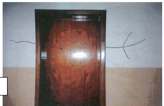
Foto das fissuras nas alvenarias. Fissuras acentuadas com tinta.
