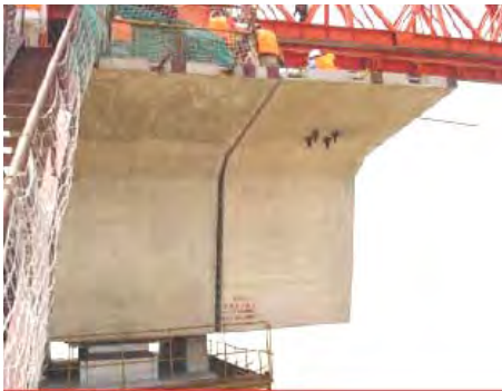
Início da montagem de uma aduela junto a um apoio. Foto de Catálogo SIKA
