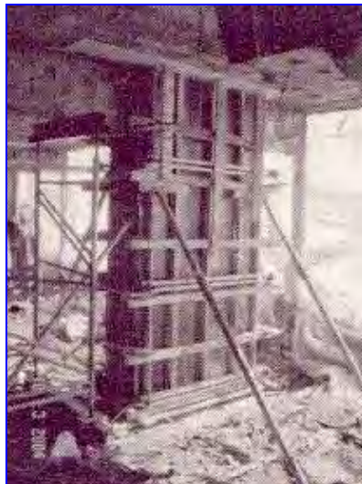
Reforço com concreto de alta resistência e com muita armadura longitudinal e estribos.
