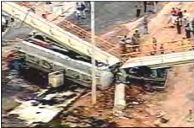
Passarela de pedestres com o pilar destruído pelo impacto de um caminhão tanque.
