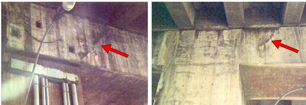
Dois pórticos apresentaram o mesmo tipo de fissura
