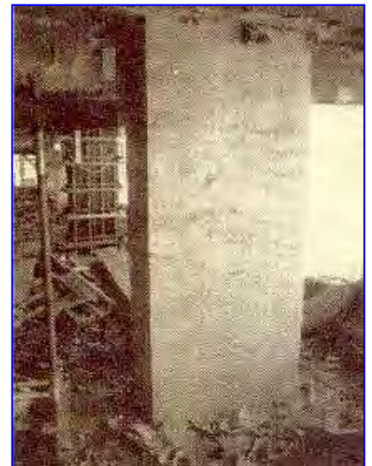
Pilar já encamisado Ver [117] - Clube de Engenharia /RJ
