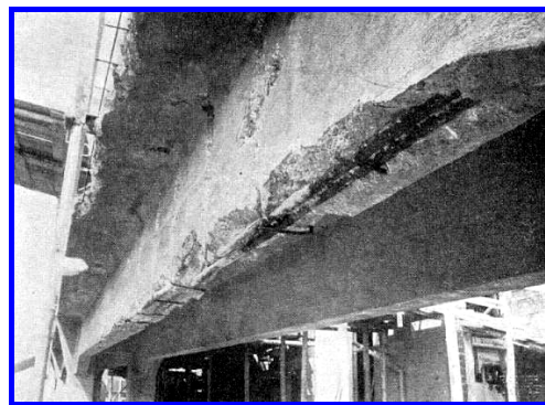
Os ferros longitudinais corroídos “explodiram” o cobrimento.
