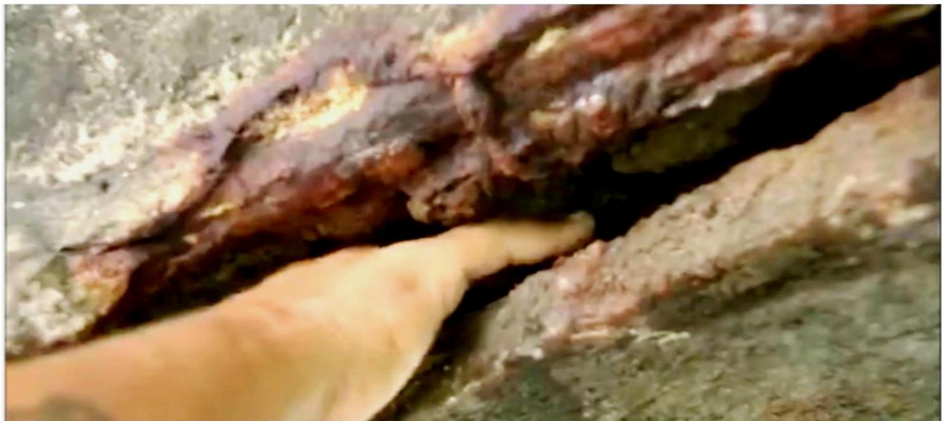
**SPALLING = DESPLACAMENTO DO FUNDO DA VIGA**
