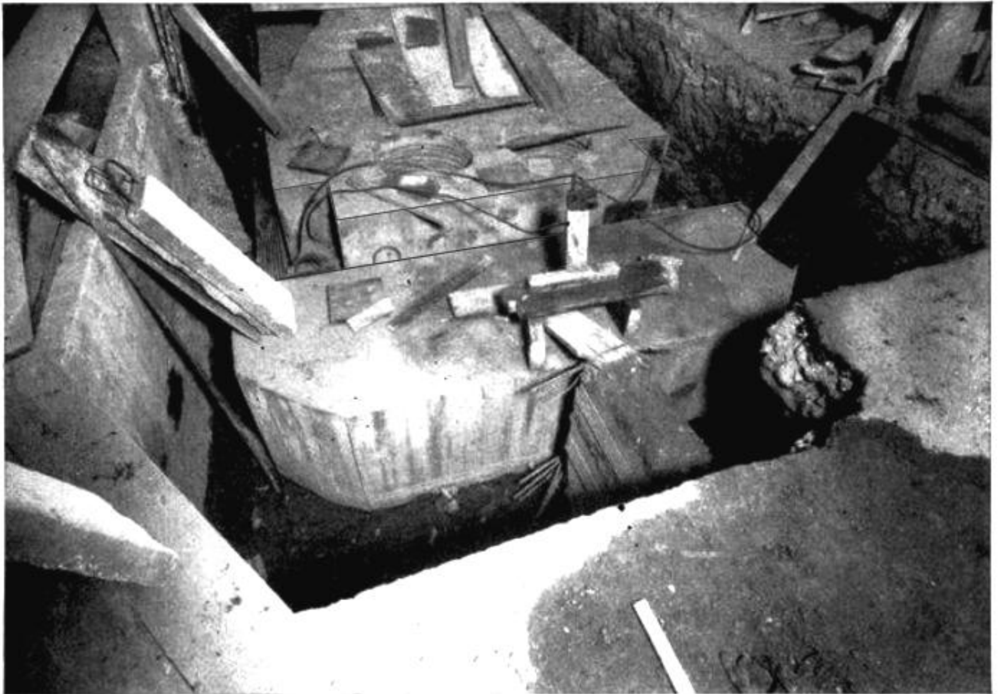
Tête mobile d'un tirant au cours d'une opération de mise en tension et calage.
