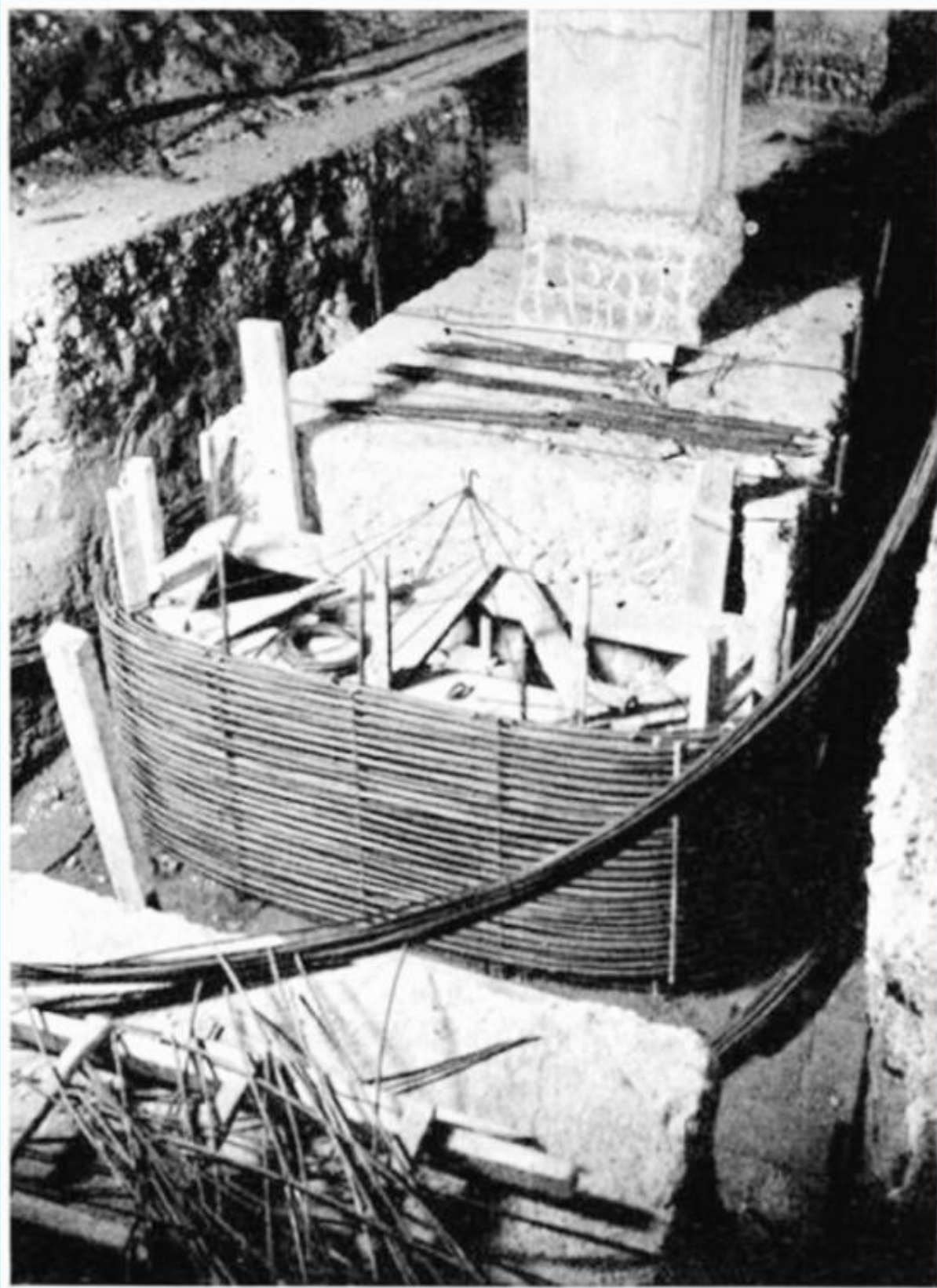
Figure 80 - Ferrailage d'une tête de tirant précontraint. Força de Protensão = 2 macacos x 1100 ton = 2200 ton
