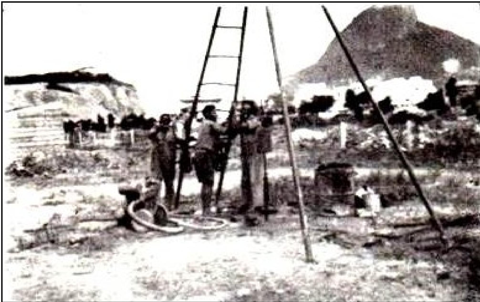
Foto n.º 4 — O aparelho de sondagem em pleno funcionamento, para as perfurações.
