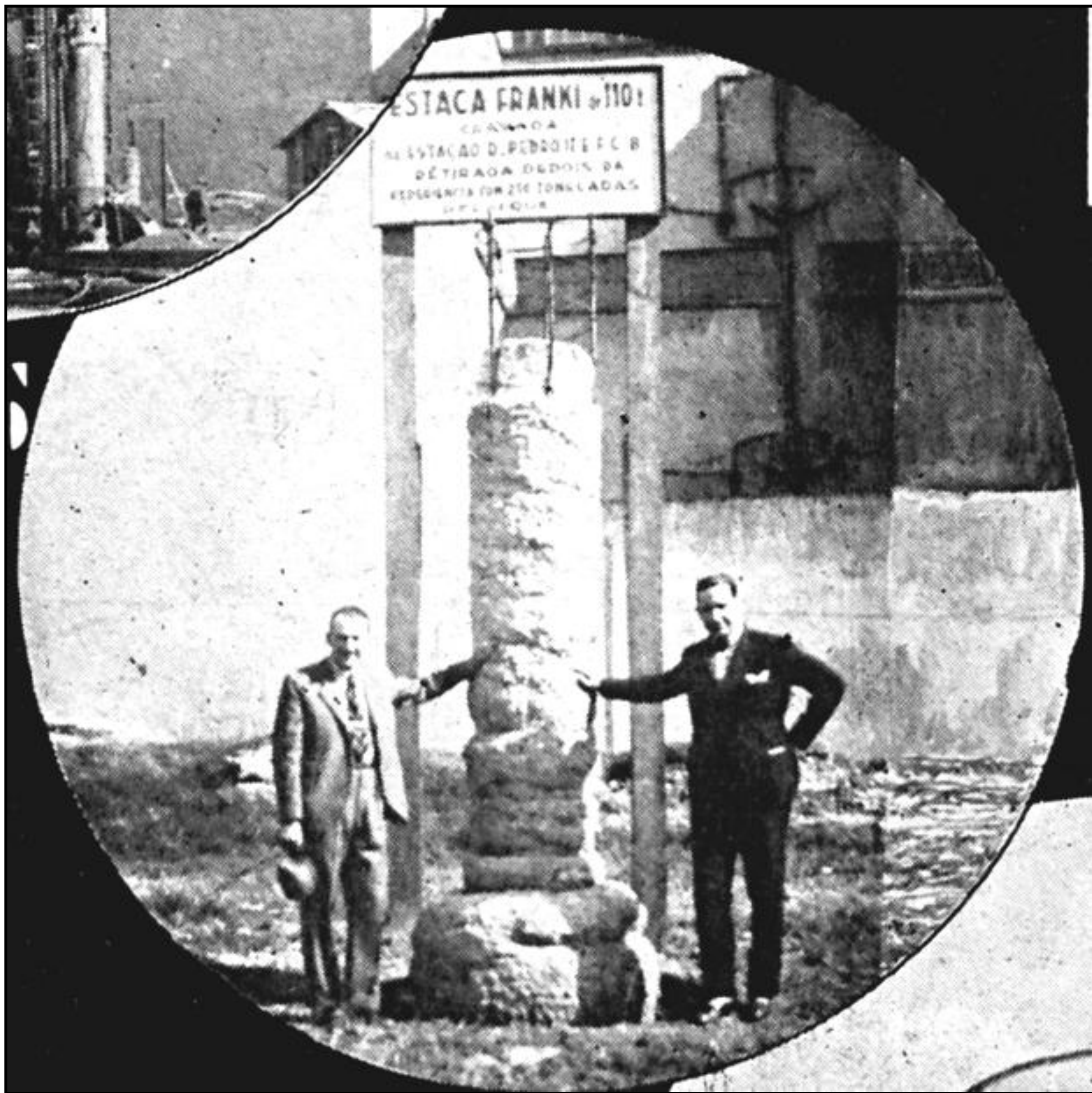
Estaca FRANKI , Desenterrada. Diâmetro =520 mm , À direita na foto Eng. Pierre Moreau, Diretor de Estacas Franki do Brasil
