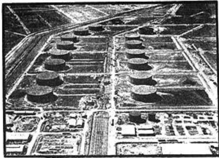
Refinaria Duque de Caxias — Fundações e Lajes de Estaqueamento
