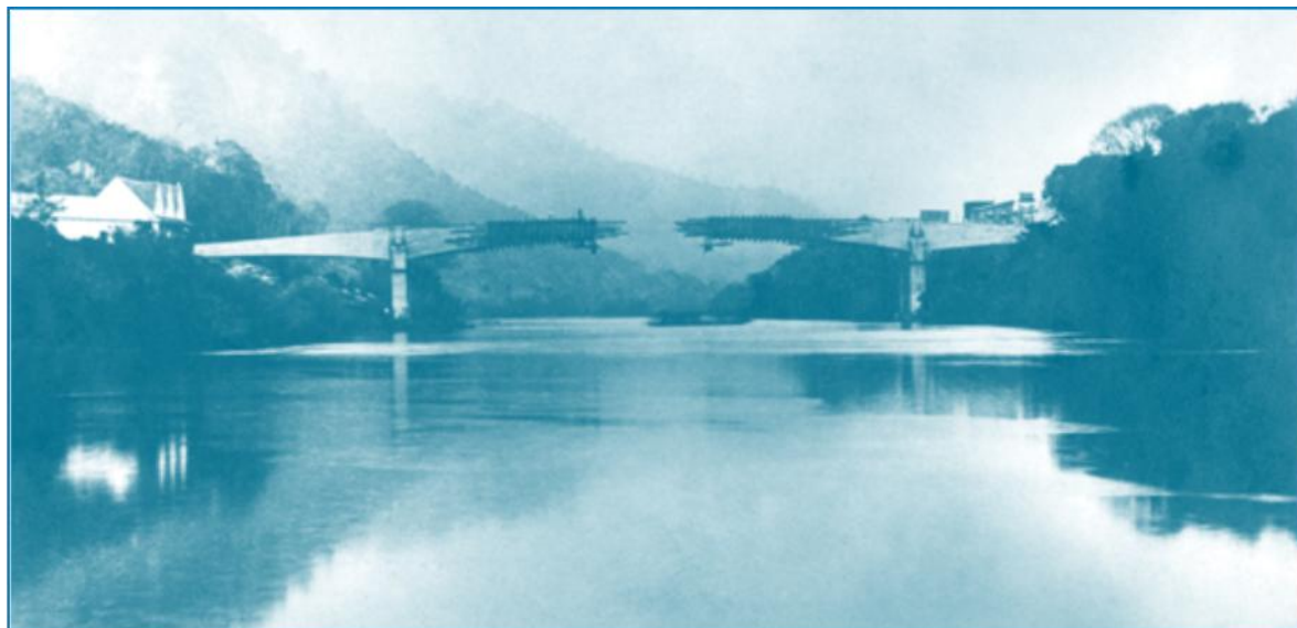
Quase fechando o vão central
