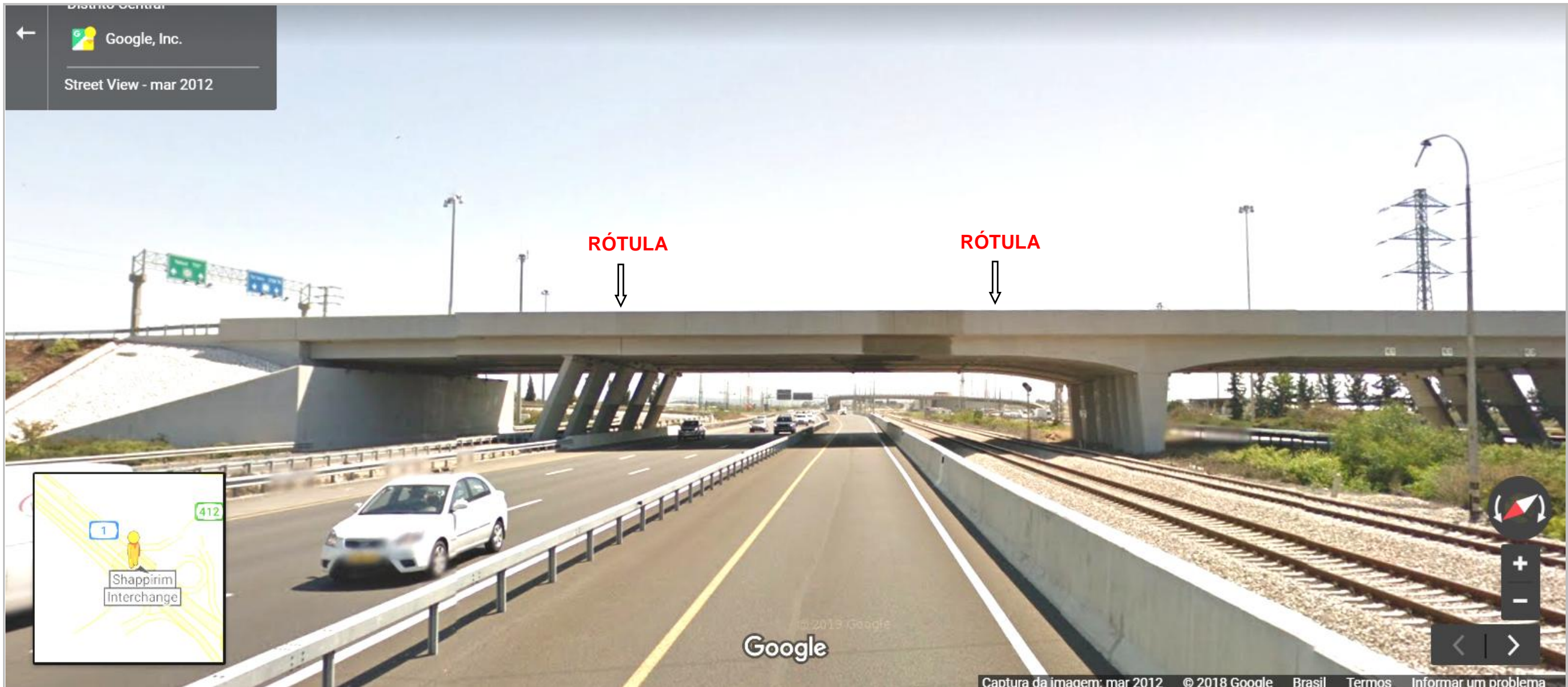
As pistas mais laterais foram abertas cortando os taludes existentes no projeto inicial.
