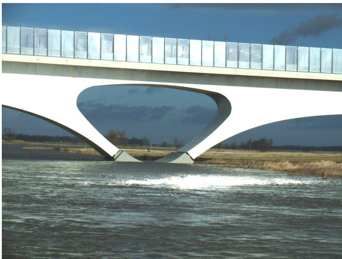
Detalhe do apoio central - Duas rótulas Mesnager
