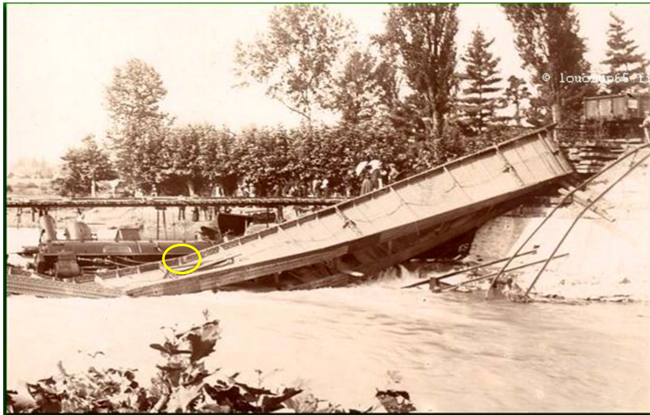
Assinalada na figura a flambagem local da mesa comprimida, numa seção com grande momento fletor, sob as rodas da locomotiva.
