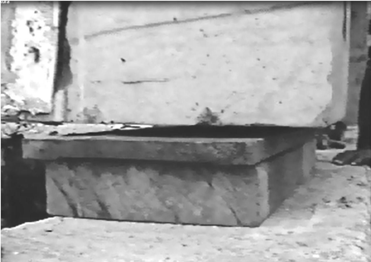
Apoios provisórios de Madeira
