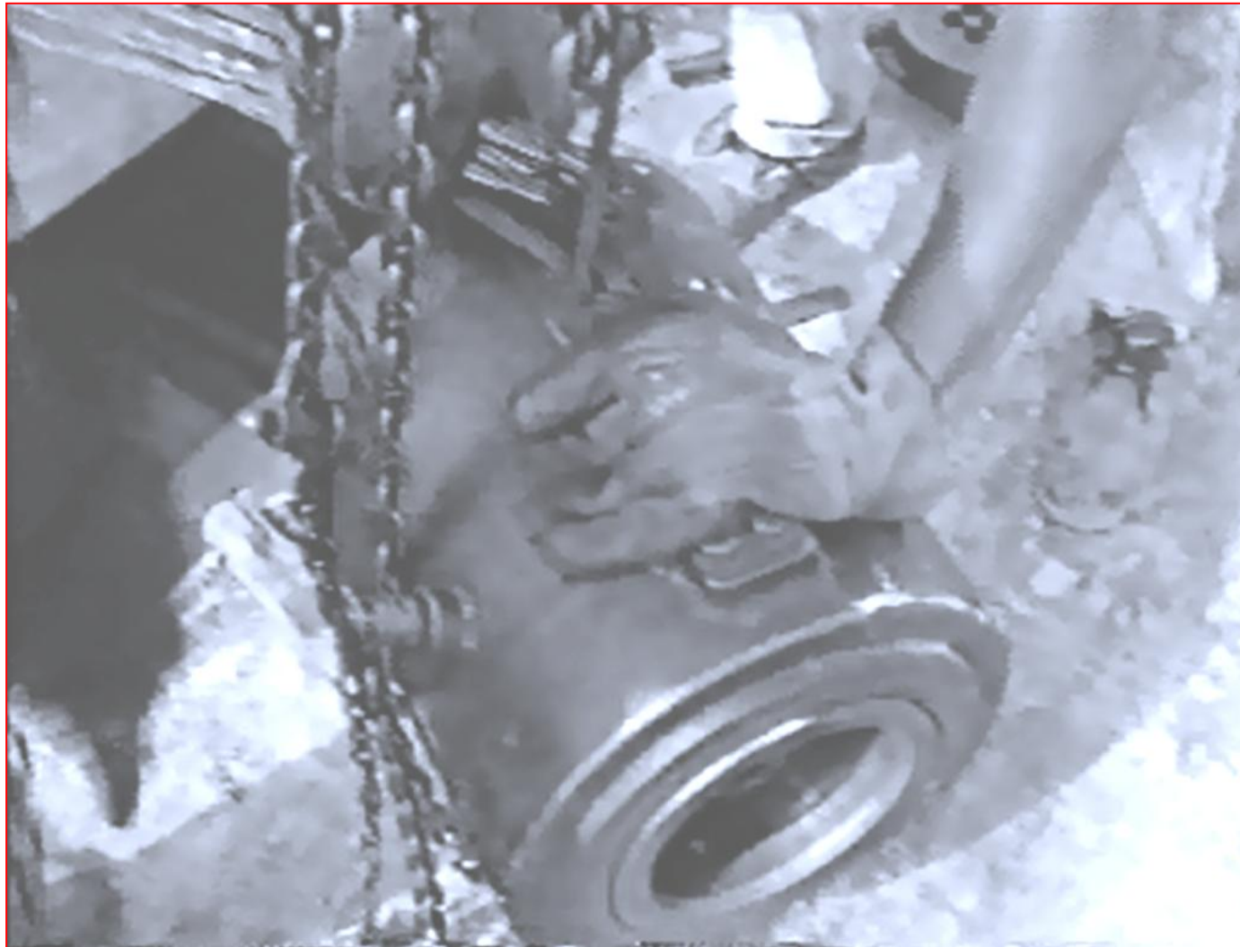
Posicionando o macaco.
