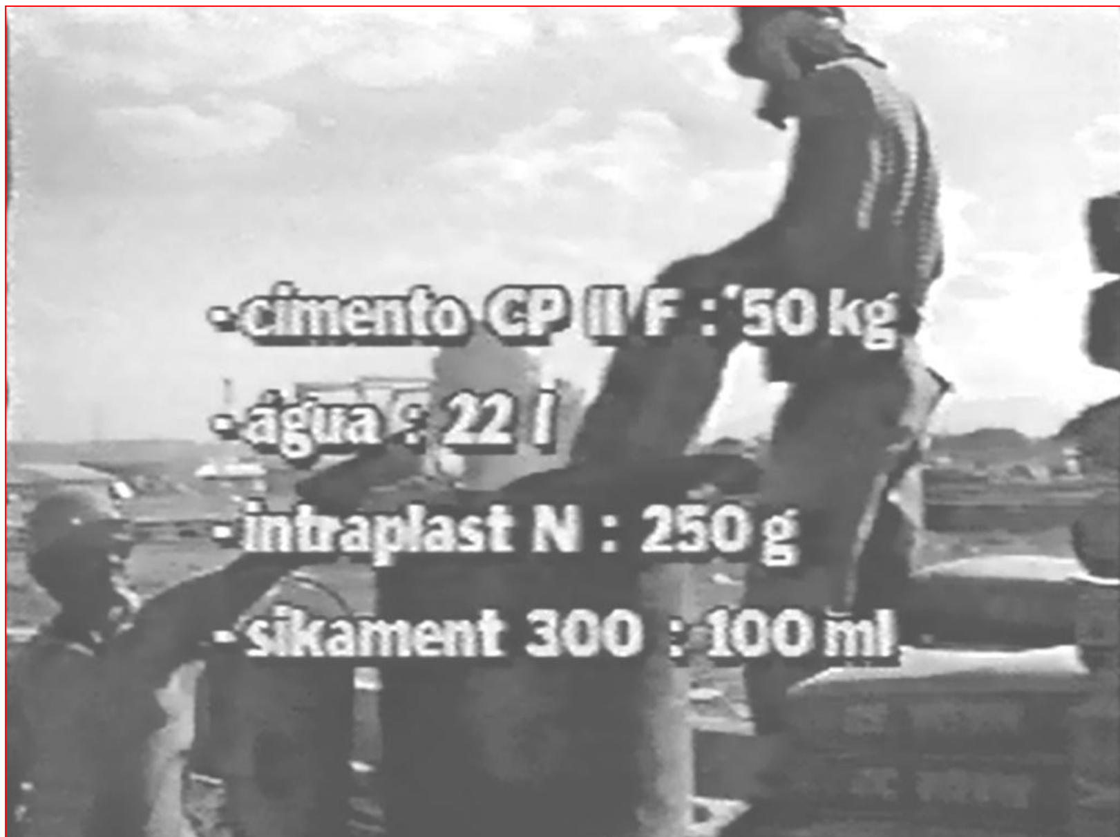
Traço da pasta de injeção dos cabos
