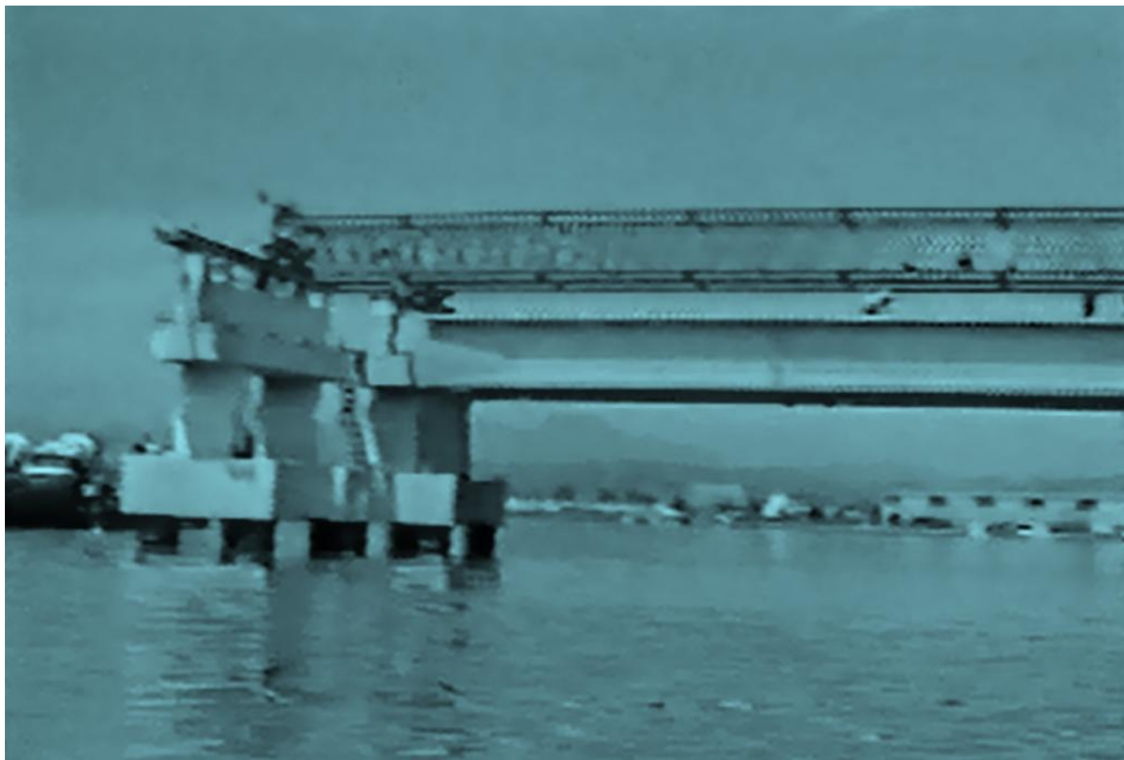
A treliça transporta a viga até o local de montagem.
