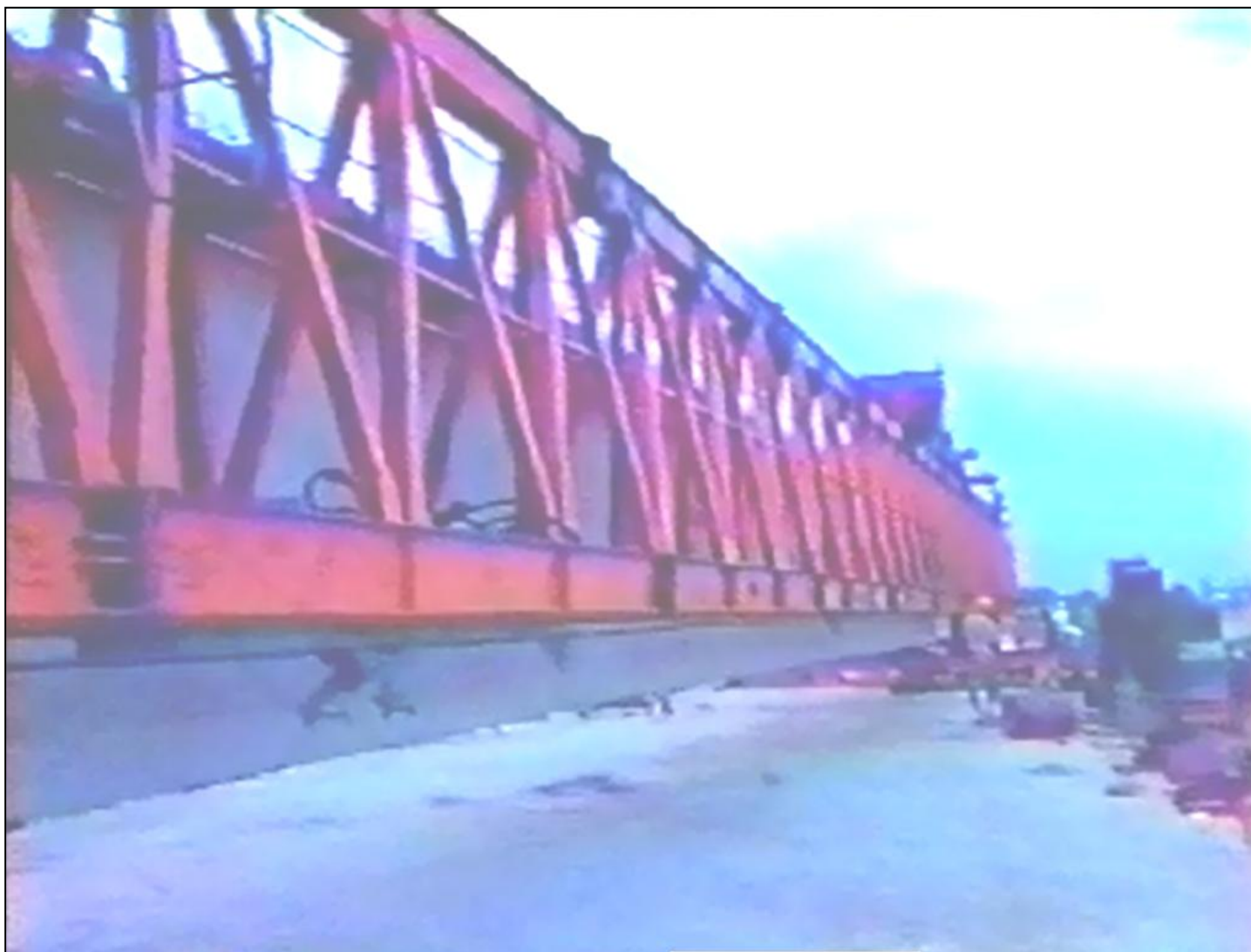
A treliça transporta a viga até o local de montagem.
