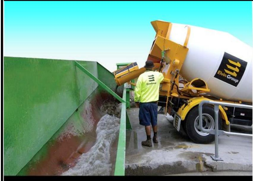
**Descarregar, no coletor, os restos de concreto misturados com a água de limpeza.**
