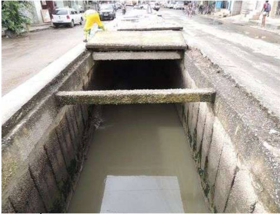
Água do Canal certamente contendo sulfatos .
