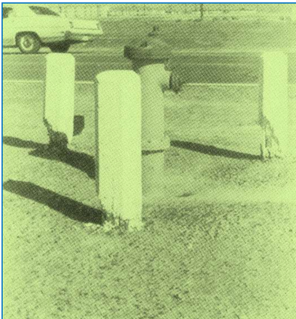
Postes de concreto danificados junto ao solo, que continha sulfatos. ( Fotografia PCA )
