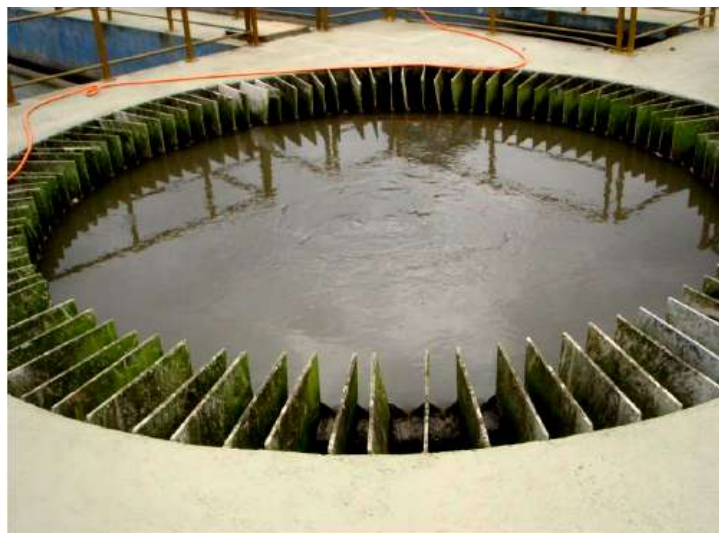
Figura 18 : Caixa de distribuição do reator Anaeróbico UASB , de onde foi retirada a amostra da água para ensaio ( 2011 )
