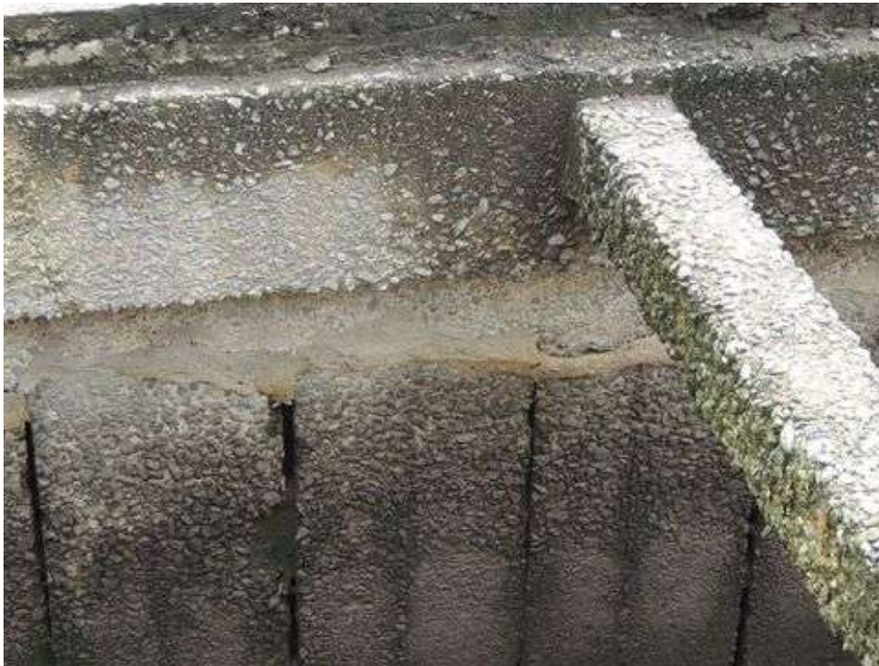
Água do Canal certamente contendo sulfatos .
