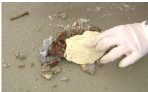
Figura 21 : Amostra de concreto extraída da parede lateral da comporta .( 2011)
