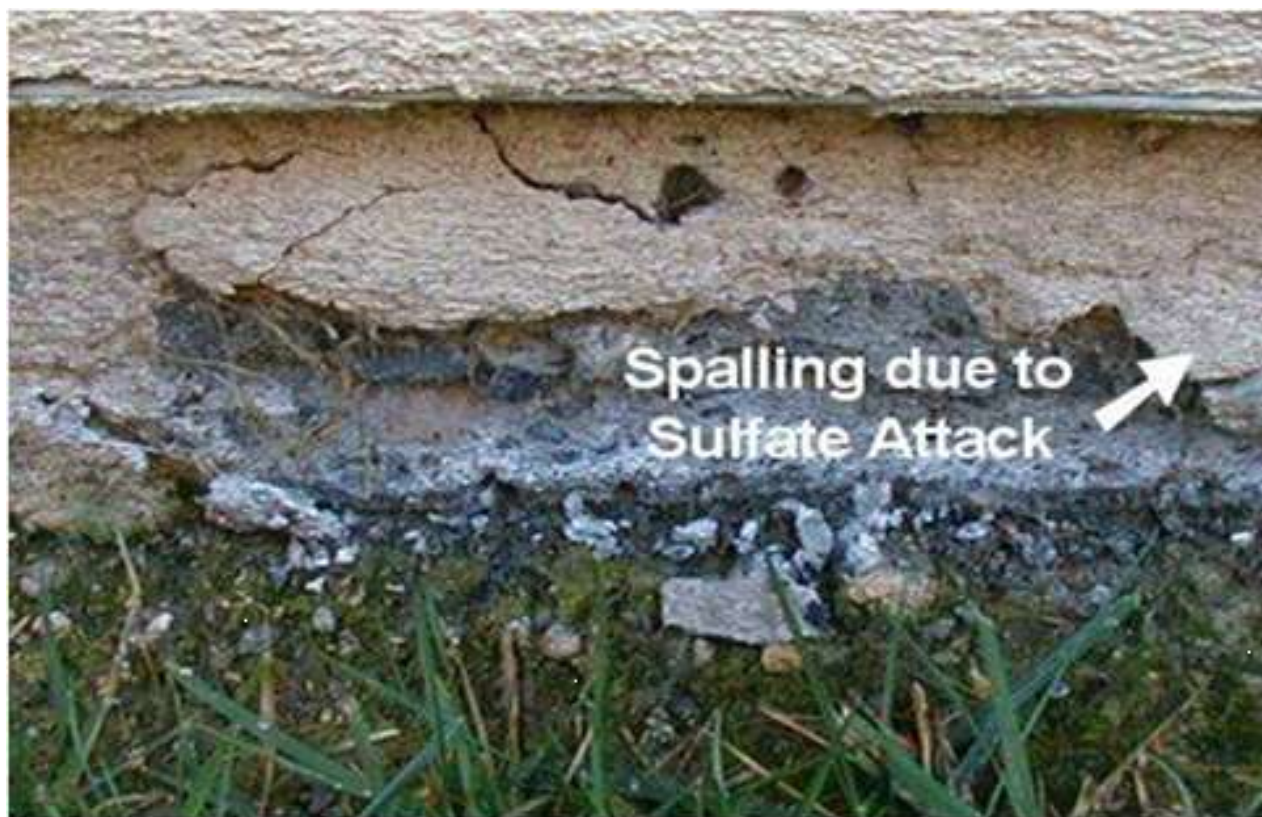
Figura 3 – Lascamento devido ao ataque por sulfato.
