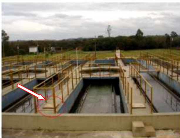
Figura 19 : Vista geral da ETE visitada para coleta de amostra de concreto . Em destaque no círculo vermelho a comporta da próxima figura. ( 2011 )
