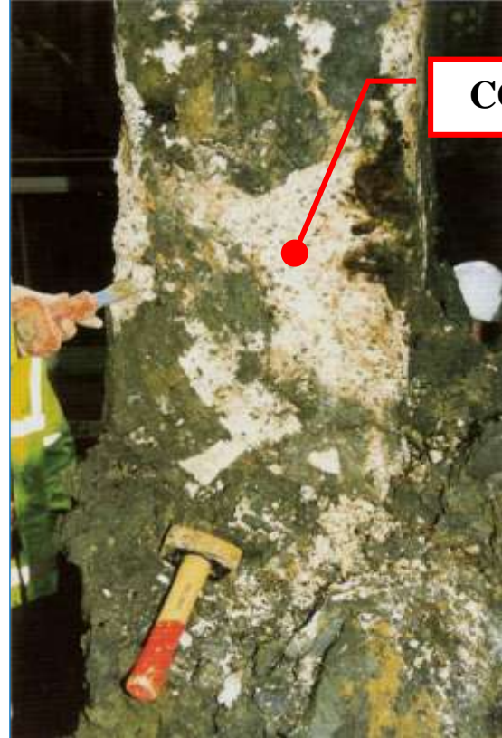
Concreto da fundação de uma ponte, deteriorado pelos Sulfatos.
