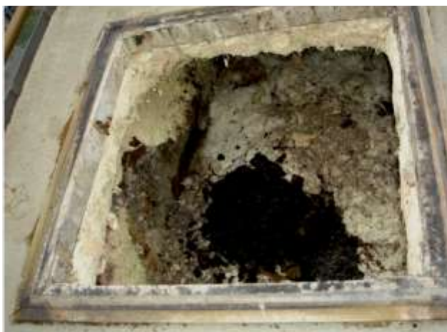
Figura 20 : Comporta aberta, cujas paredes de concreto apresentavam uma camada amarelada evidenciando a presença de enxofre. ( 2011 )
