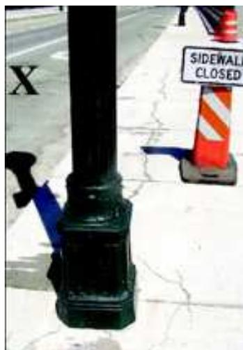
Fig. 2 - A nova ponte na Rua Washington e na I-25 tem fissuras nos passeios, no pavimento e nas barreiras.
