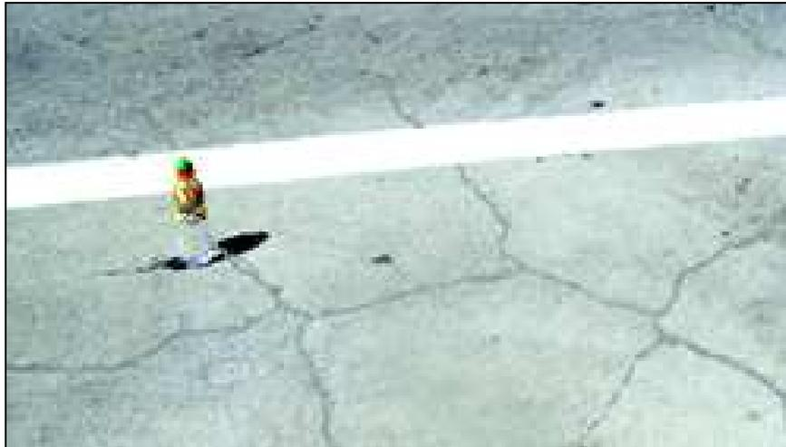
Fig. 3 – A fissuração em forma de mapa é claramente evidente no piso da nova ponte na I-25, na Rua Washington. Photo : Richard Burrows
