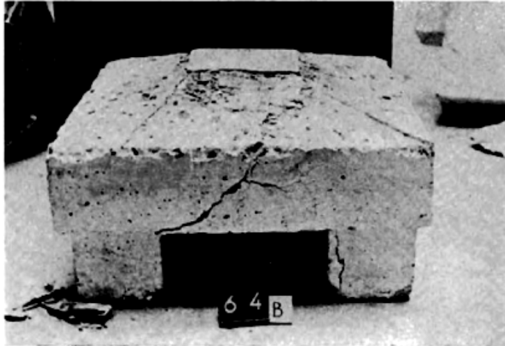
6,4. Rupture avec fissure inclinée et écrasement du béton à la partie supérieure.
