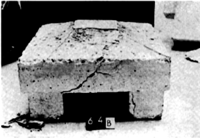
6,4. Rupture avec fissure inclinée et écrasement du béton à la partie supérieure.
