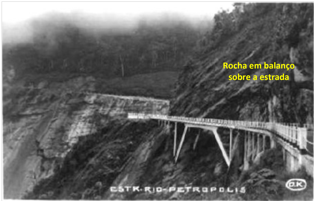
Viaduto 3- Rocha em balanço por sobre a pista.
