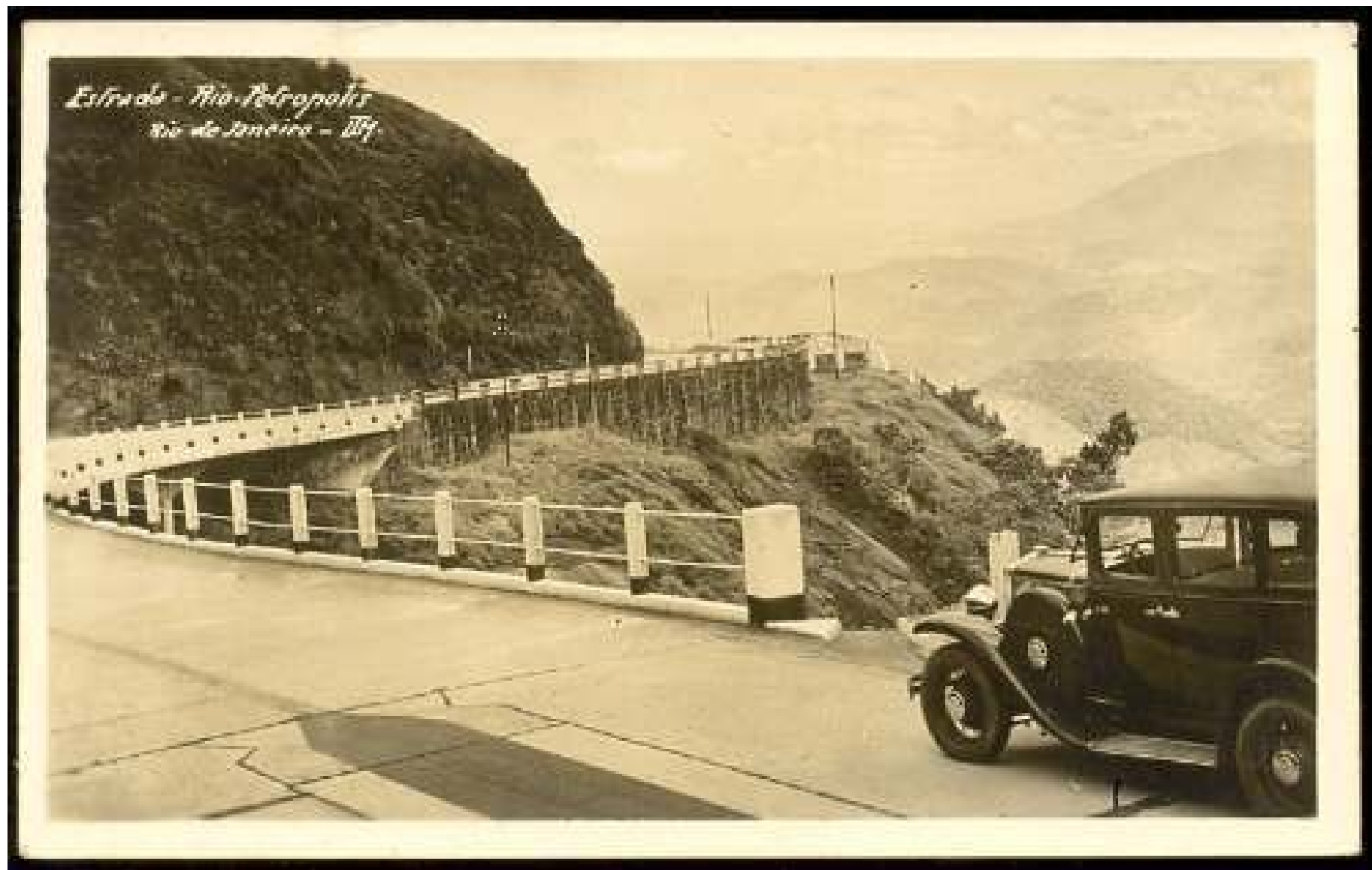
Pavimento de concreto
