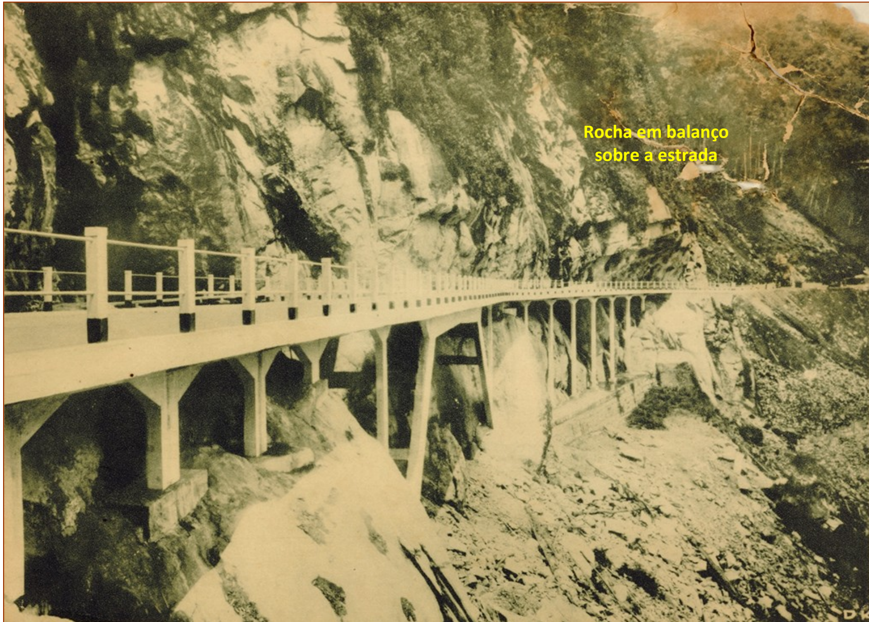
Acervo do Museu Imperial - http://187.16.250.90:10358/bitstream/acervo/5131/1/CF-A.05-06r%5Bfrente%5D.jpg O tabuleiro parece estar apoiado sobre pilares de um dos lados e sobre a rocha do outro lado.
