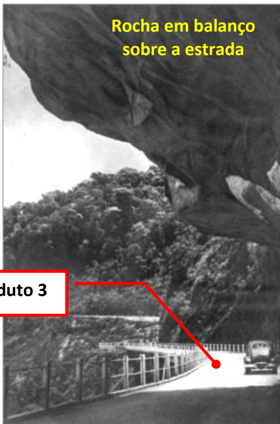
Viaduto 3- Rocha em balanço por sobre a pista.
