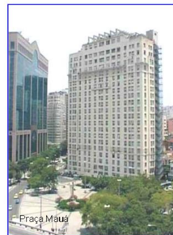
2013 - Prédio em reforma
