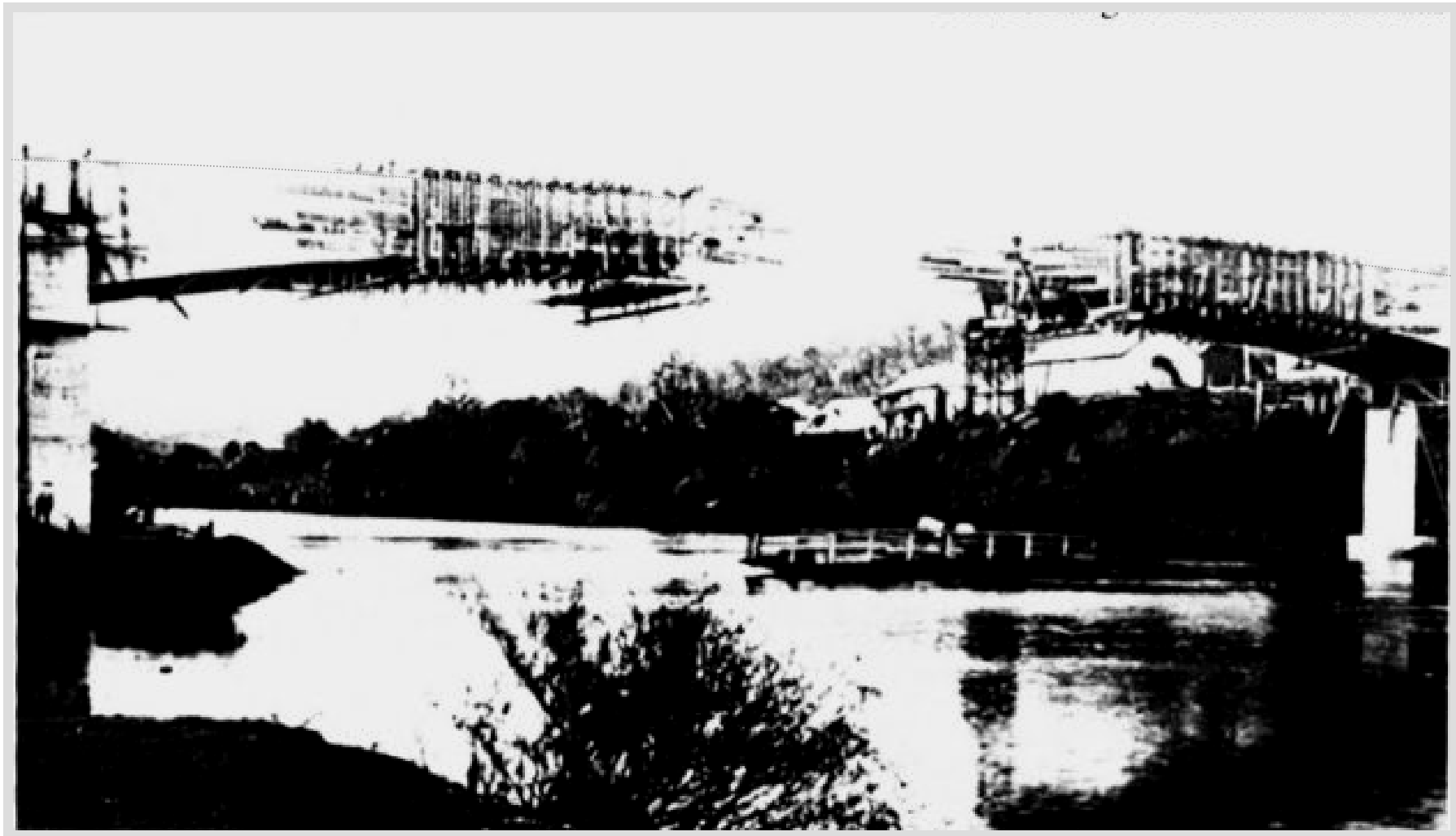
Fase intermediária da obra.
