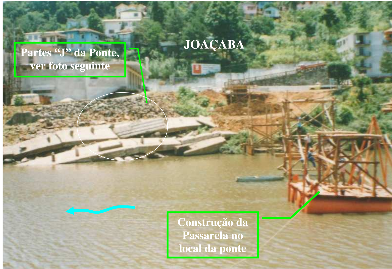
Construção de Passarela no local da Ponte que caiu.
