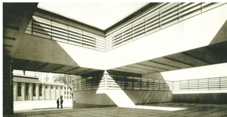
Figura 2 – Acesso principal do albergue mostrando a permeabilidade entre o espaço urbano e o pátio do edifício. Notar a ausência de pilares de sustentação do pavimento superior e o jogo estrutural de vigas e pilares de transição sobre as vigas
