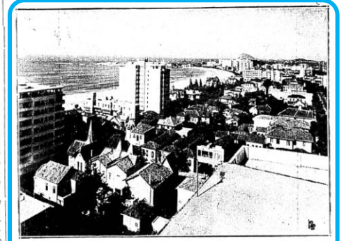
Bellissima vista panoramica de Copacabana, apanhada de um dos terraços do Edifício "Roxy"
