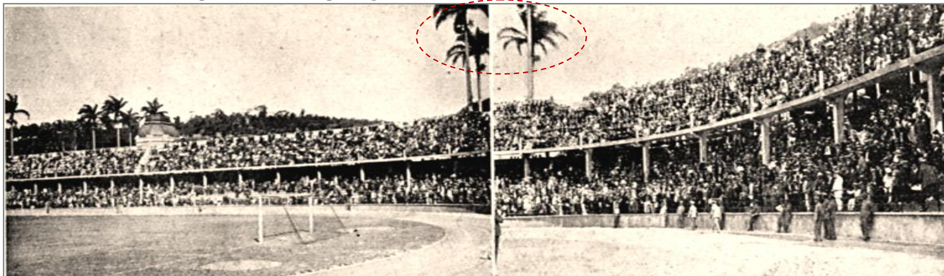
As novas arquibancadas projetadas por Emílio Baumgart.
