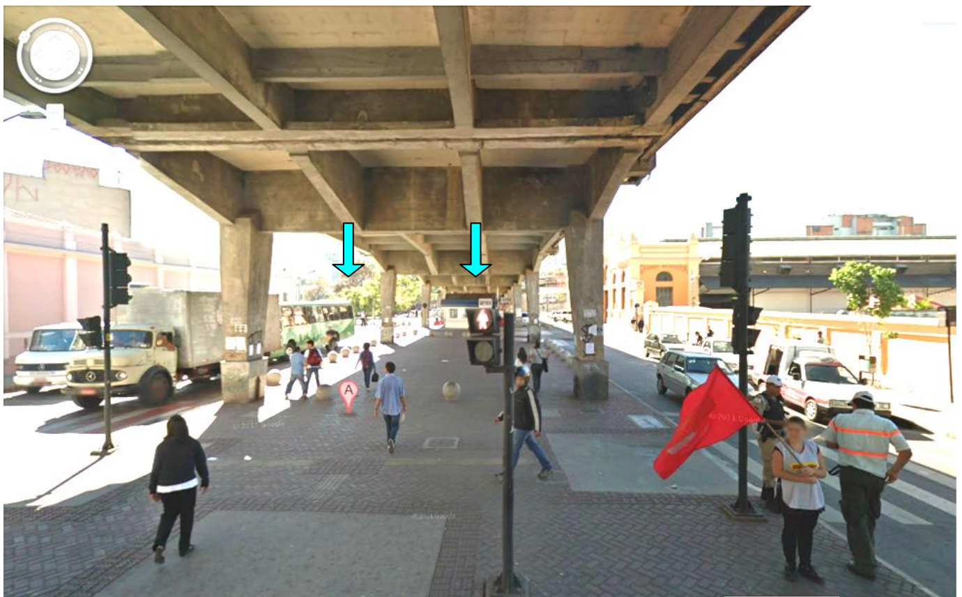
2013 - As travessas de apoio estão solicitadas por duas grandes cargas aplicadas pelas duas vigas longitudinais centrais. Em 1928 o tabuleiro foi calculado para um caminhão tipo de 24 ton, então usado pela norma alemã. Usava-se, para dimensionar os estribos e os ferros dobrados, a treliça de Moersch original, com diagonais a 45 graus e sem qualquer redução na armadura de cisalhamento ( estribos + ferros dobrados ).
