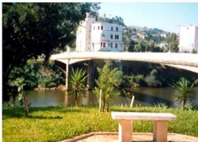
Cabos elétricos fixados à ponte
