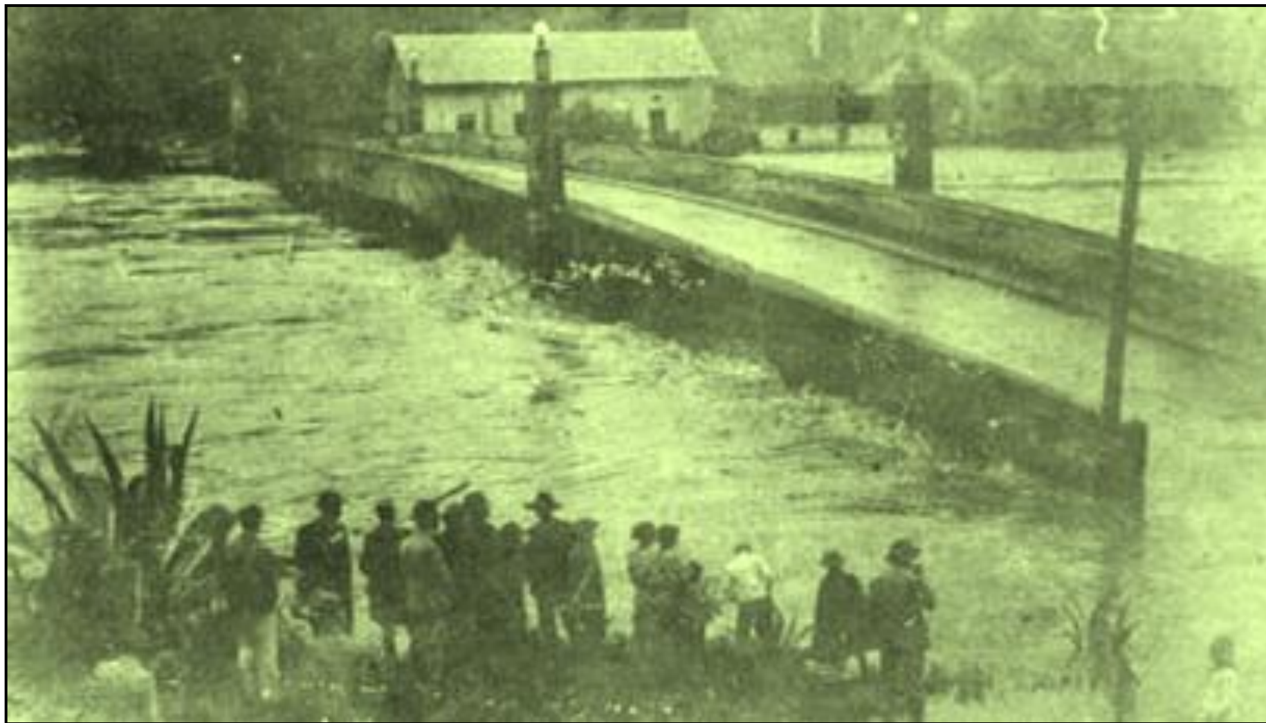
Fig. 5 Em várias enchentes as águas subiram mais de 10m e atingiram a viga da ponte.
