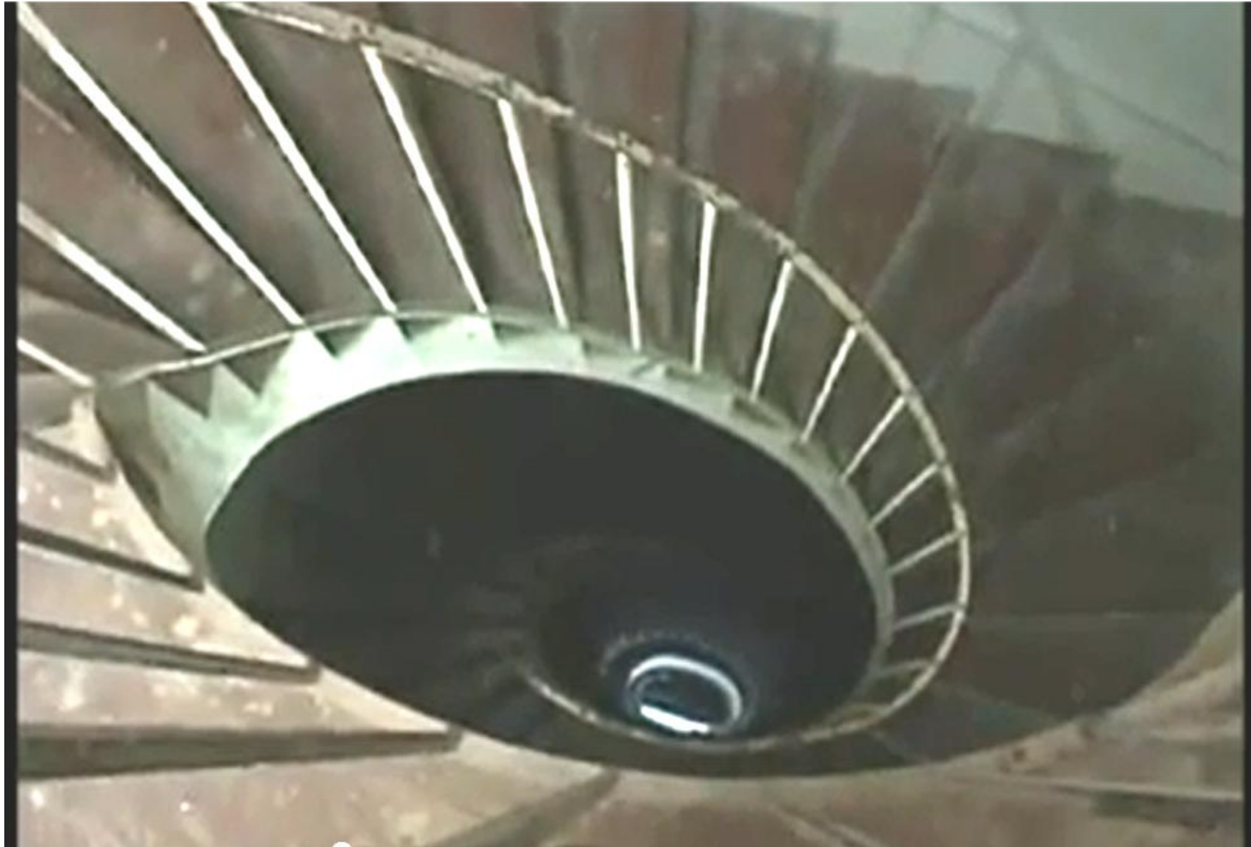
GRANDE ESCADA CARACOL SEM VIGA NO BORDO , EM TODA A ALTURA DO PRÉDIO
