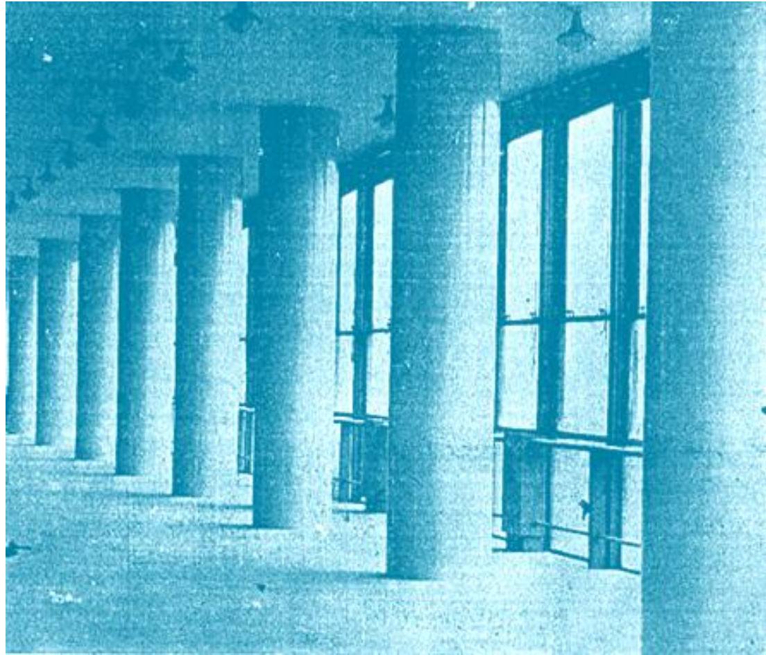
Vista interna de um pavimento - Lado Fachada Sul
