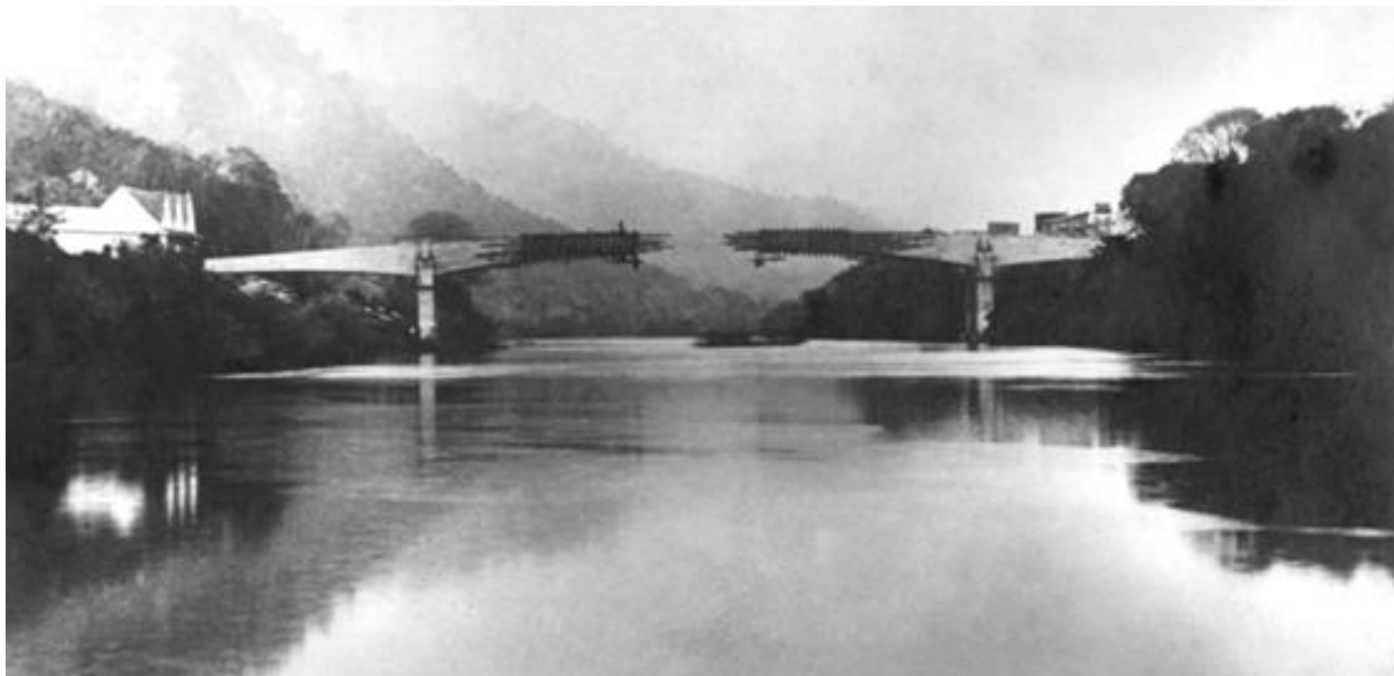
Fig. 4 -- A ponte "Emílio Baumgart" na fase em que se dava a materialização do esquema da figura 1
