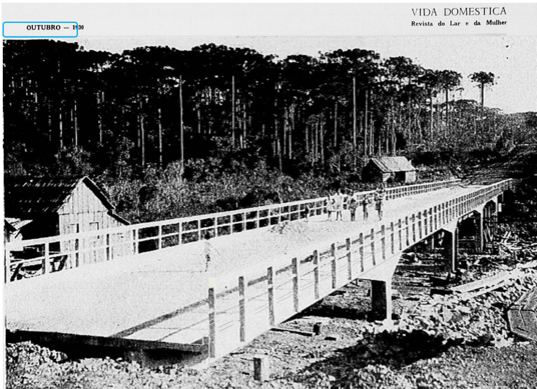
Uma ponte de cimento armado, com 127 metros de vão, construída sobre o Rio Jangada,
