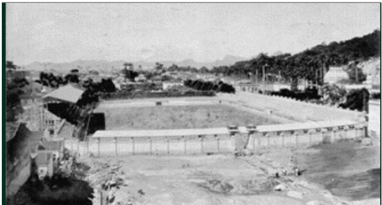
Foto do Estádio ainda em construção 1917/1918
