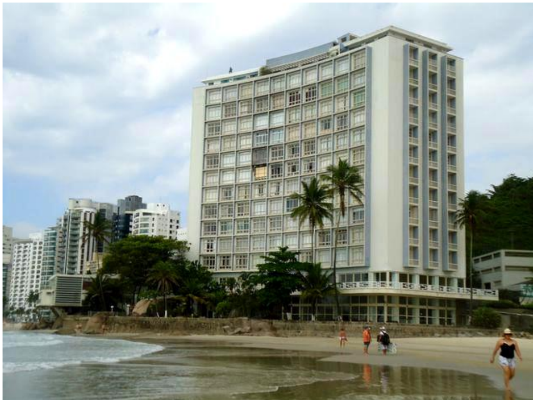
Figura 11 - Vista atual do Edifício Sobre as Ondas (Guarujá-SP)
