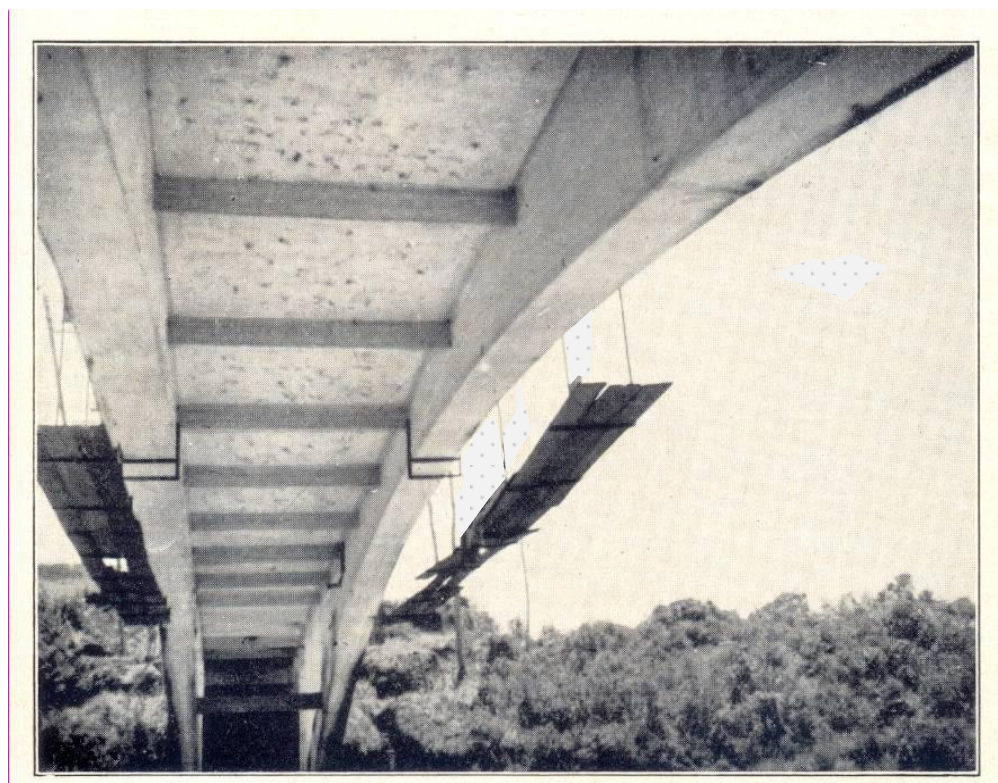
Vista interior mostrando as transversinas do tabuleiro.
