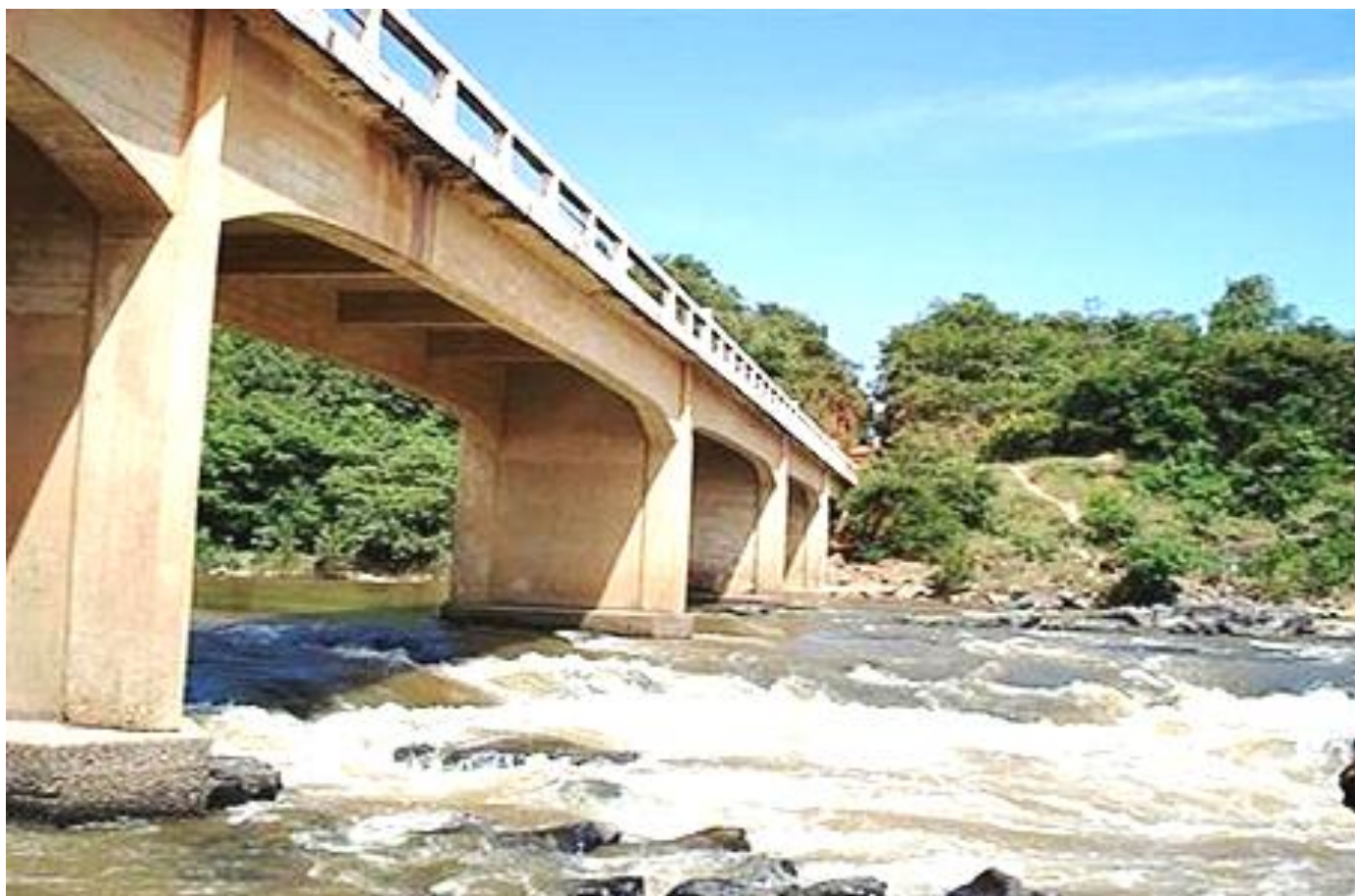
Estrutura com viga contínua de altura grande nos apoios e com muitas transversinas, como era usual nas pontes de Emílio Baumgart.
