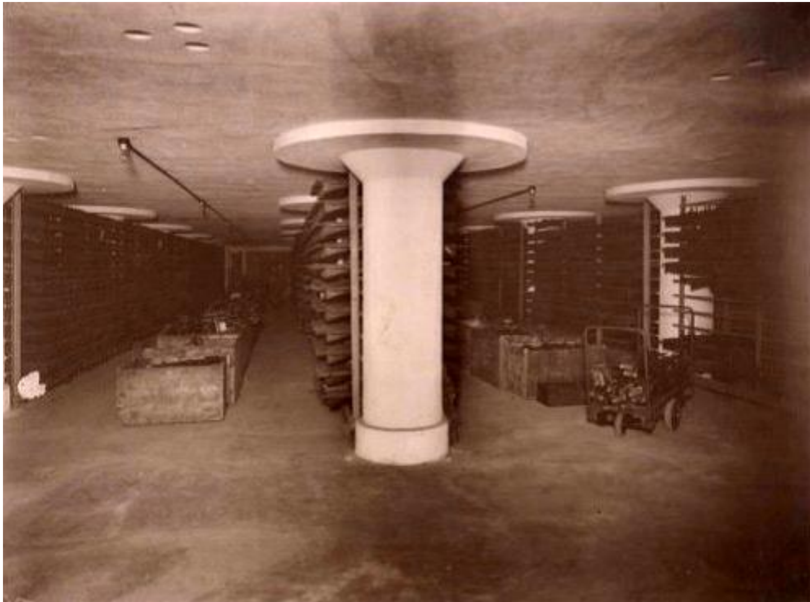
LAJE COM COGUMELO CIRCULAR DE CONCRETO ARMADO
