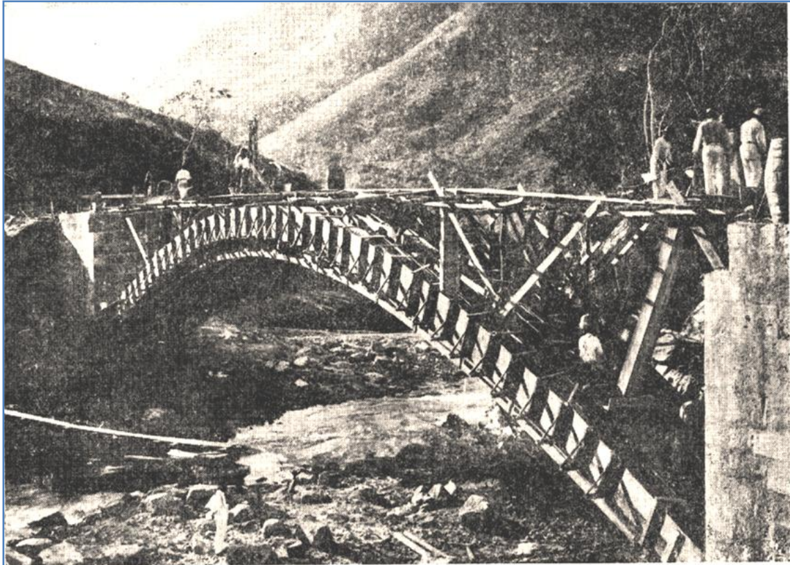
Fig. 43 — Ponte do Areal (Estado do Rio), mostrando os arcos de madeira para escoramento da ponte.
