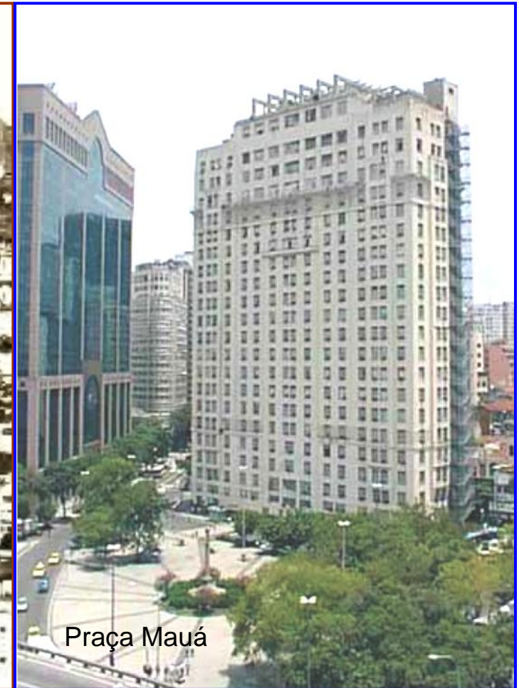
2013 - Prédio em reforma
