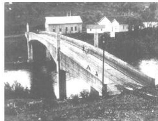
Ainda sem os acessos adequados.
