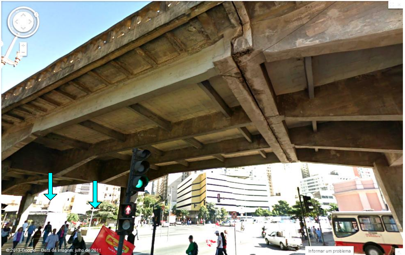
2013 - Como acontece em todas as juntas, existe passagem de água de chuva.
