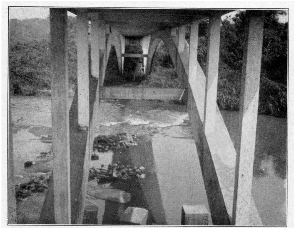
Vista inferior mostrando os pilares
