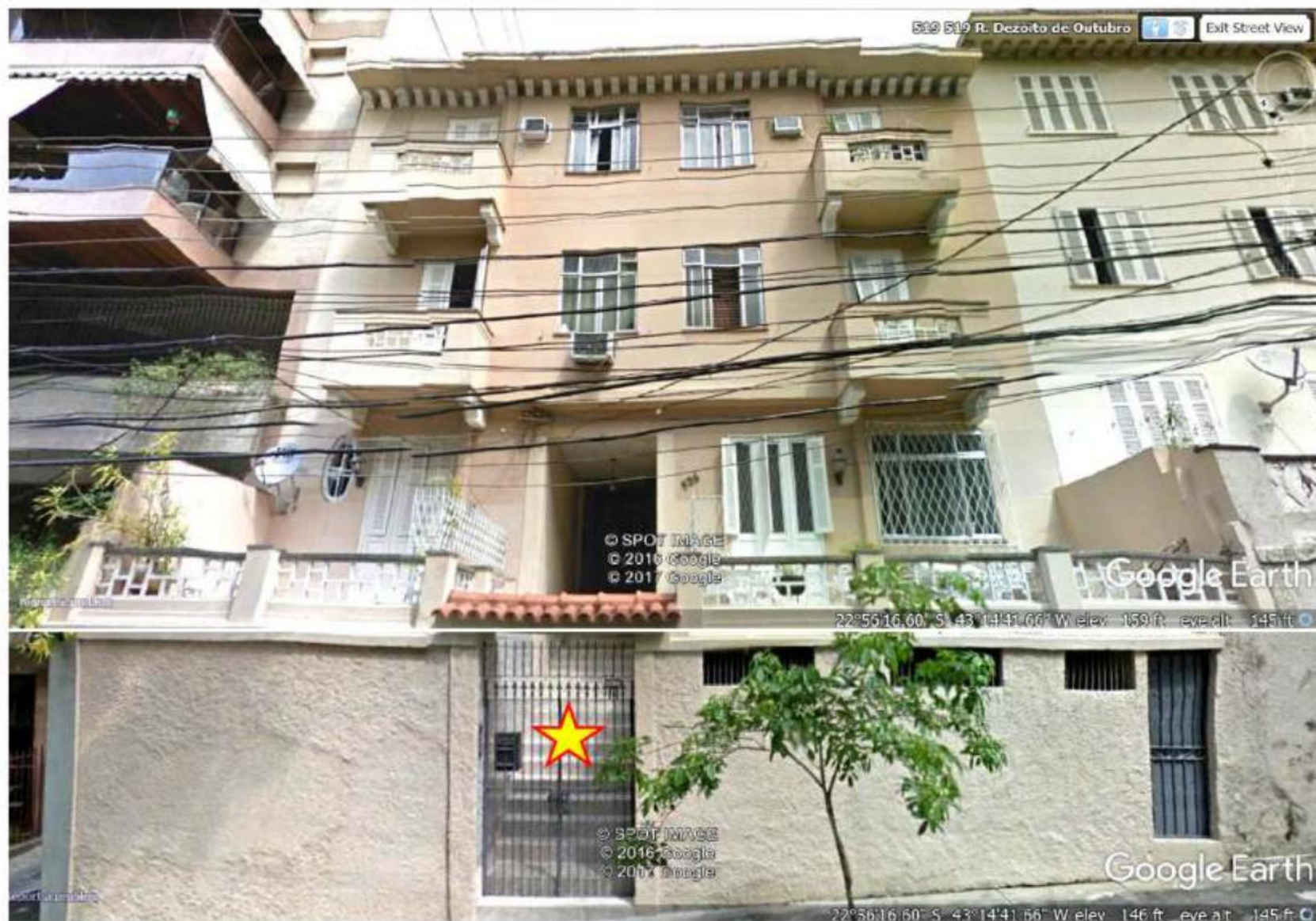
2 FOTOS GOOGLE UNIDAS - ORNAMENTAÇÃO DA FACHADA É TÍPICA DA DÉCADA DE 1940, COM CONSOLOS SOB AS VARANDAS E SOB O BEIRAL
