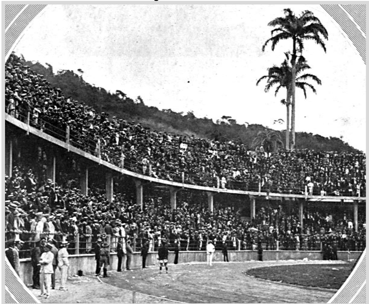
As novas arquibancadas projetadas por Emílio Baumgart.
