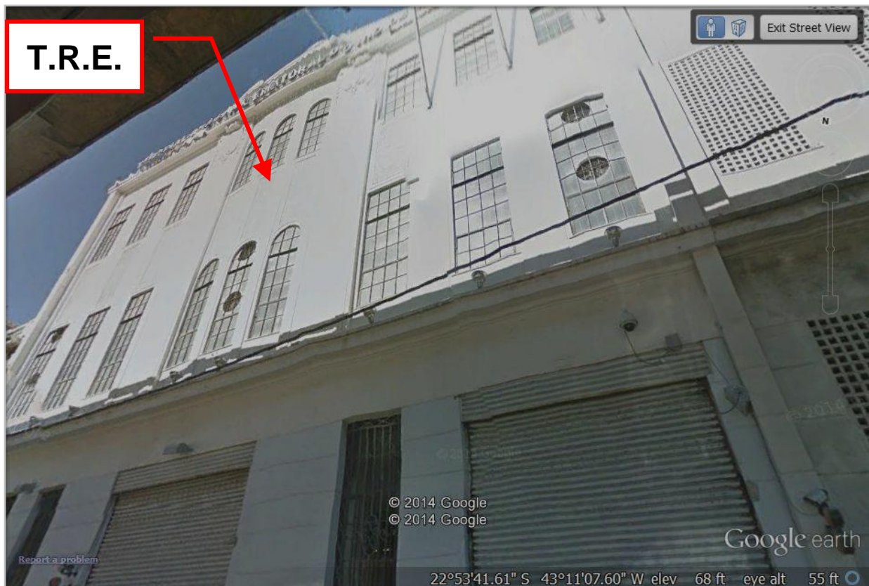
Vistas por baixo do Elevadoda Perimetral
