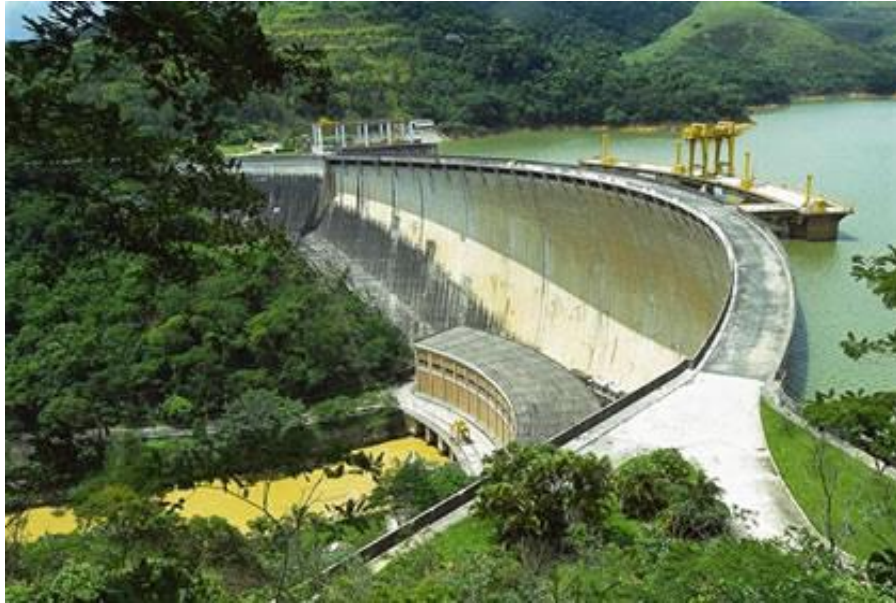
Obra projetada com apoio em modelos reduzidos 1969
