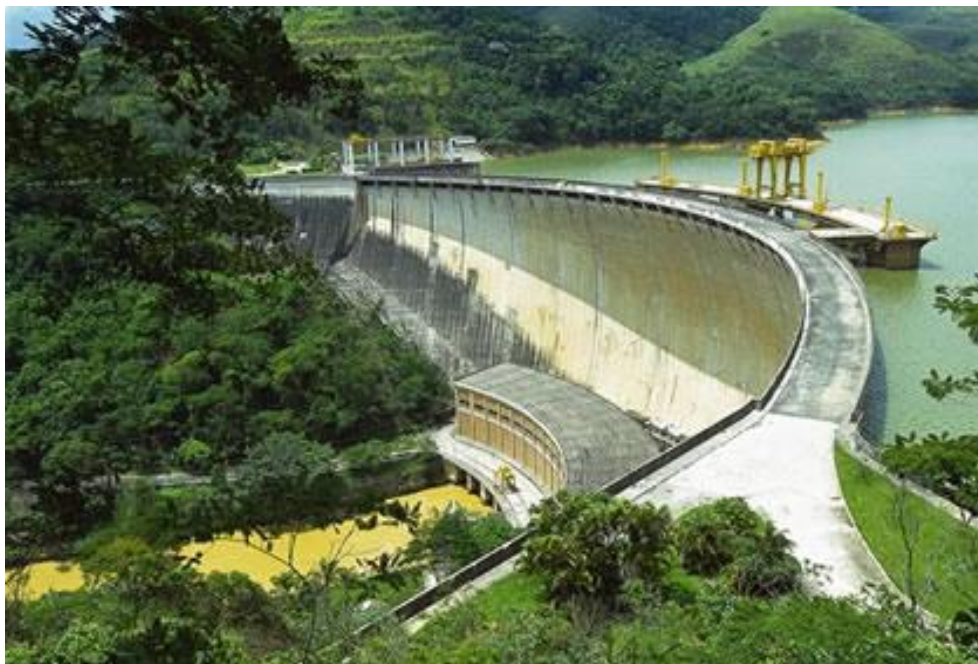
Barragem do Funil - RJ / Brasil - 216 MW.
