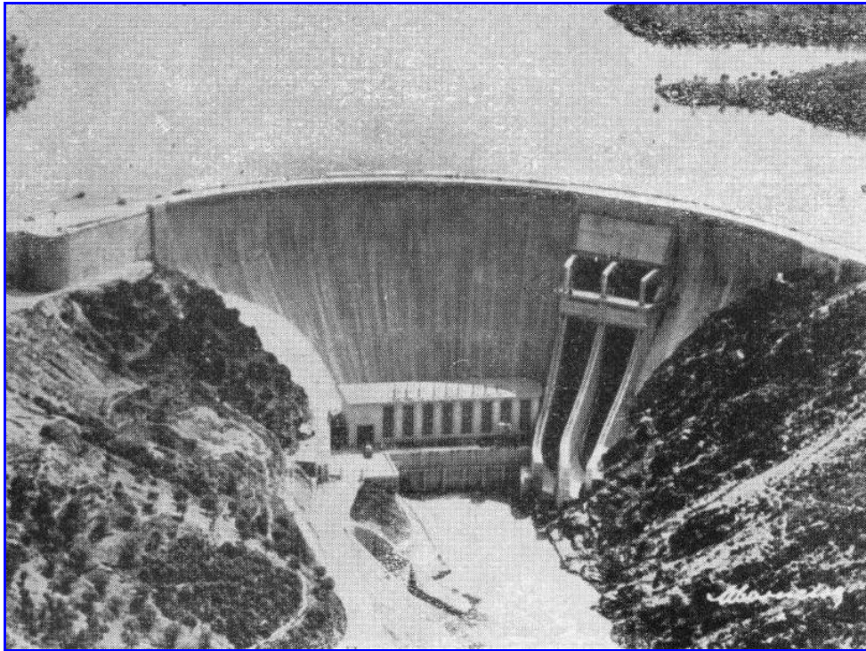
Fig. 1-A Barragem do Castelo do Bode (1)
