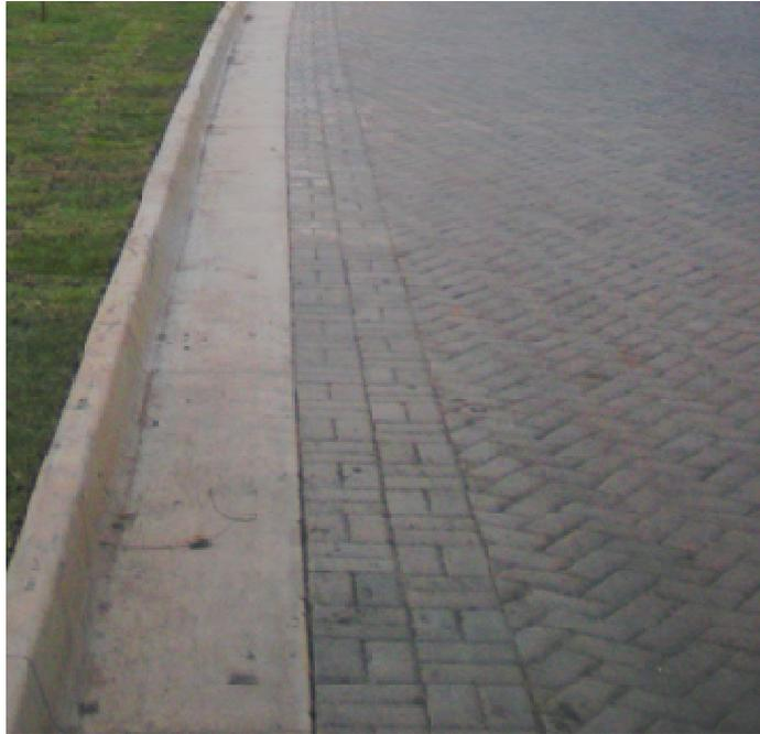
Figura 1 – Meio-fio associado à sarjeta, tabeira e pista em blocos de concreto intertravado.
