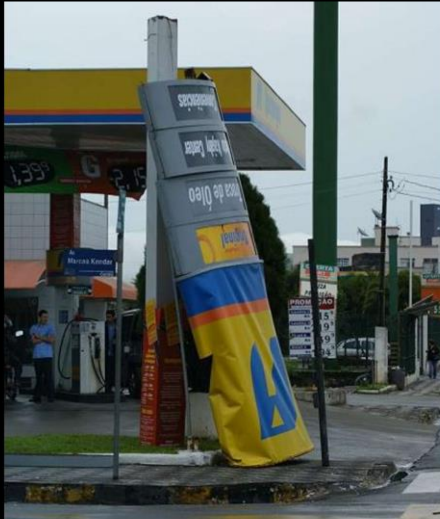
Placa de posto de gasolina despencou por conta do vendaval que atingiu a cidade de Itajaí, em Santa Catarina
