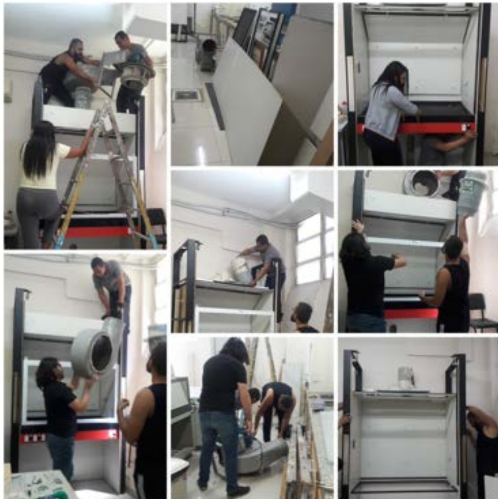
Figura 33 – Ilustração das etapas de montagem do ambiente de exaustão exclusivo.
