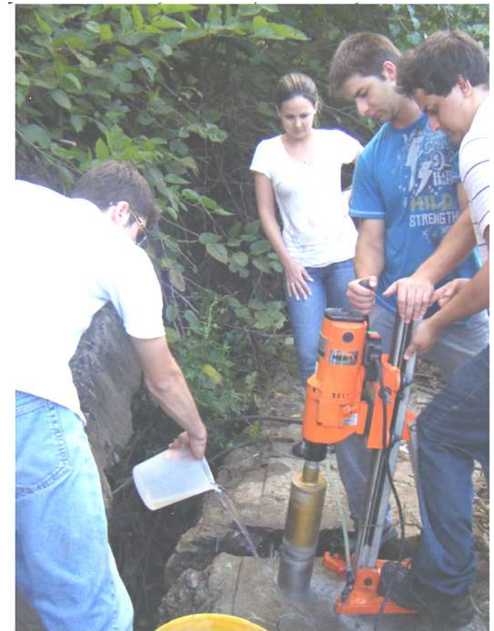
Retirada de corpos de prova para ensaios de compressão
