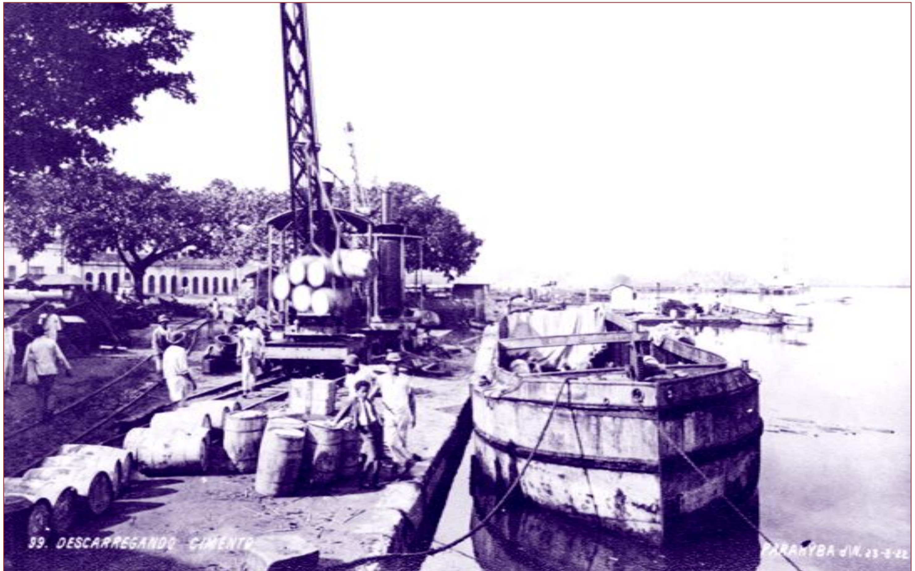
99 DESCARREGANDO CIMENTO = PARAHYBA d | N. 23-8-22
