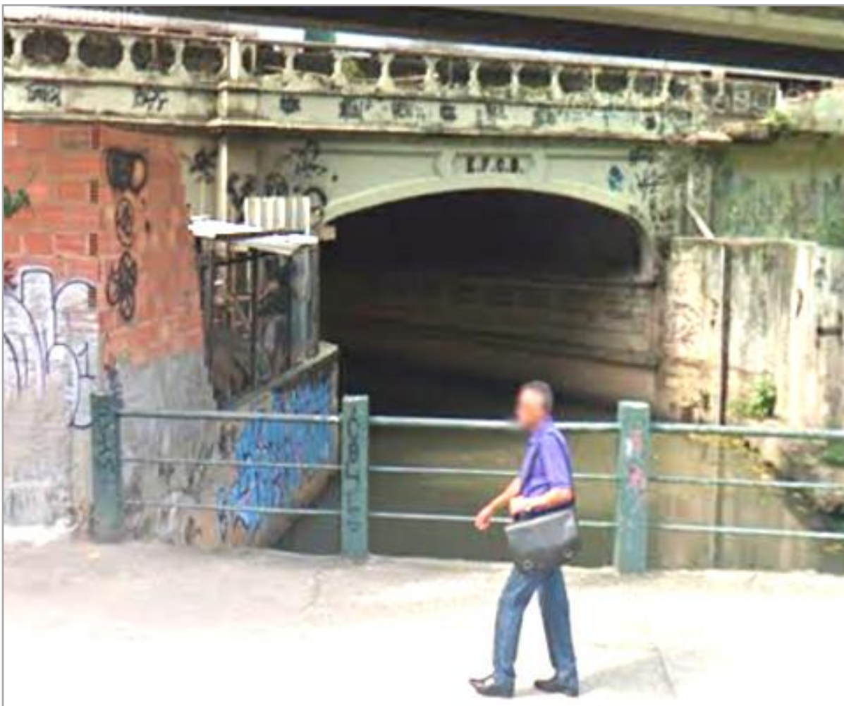
OBRA CONSTRUÍDA COM CIMENTO IMPORTADO
