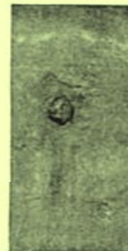
Jorro recolado com o SIKKA n. 2. Superfi- cie pronta para um reboco protector de SIKKA n. 1.
